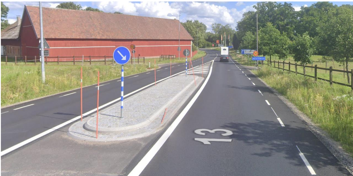
Figur 33 – Exempel tätortsport byggd i Röstånga (Källa: Google Street view)
