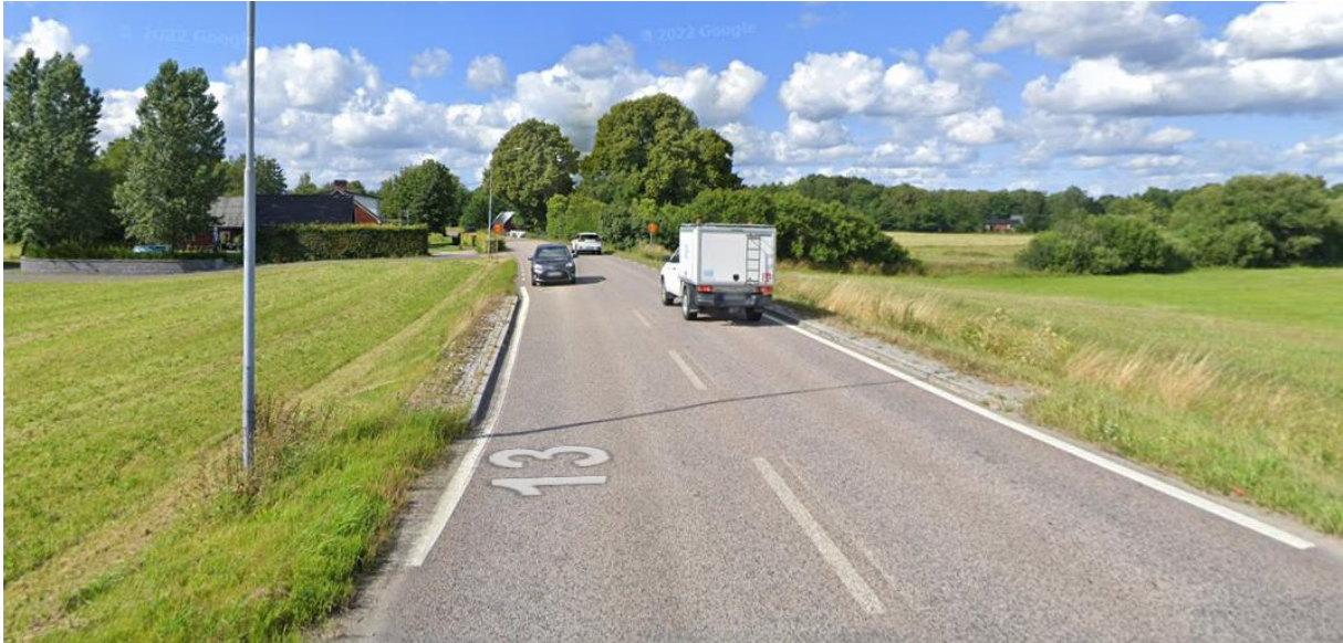
Figur 32 - Befintlig tätortsport i Billinge (Källa: Google Street View)
