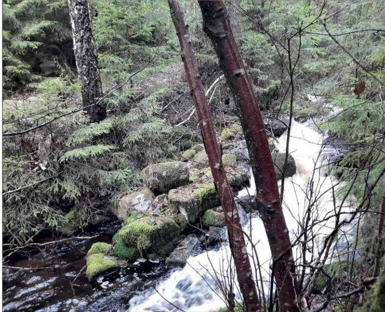
Figur 17. Rester av kvarngrunden vid bäckens västra strand, foto: Christina Rosén, Arkeologerna Statens historiska museer, hämtat från rapporten Kvarn och klippöverhäng–inventering i gränsbygd, Rapport 2022:9, Arkeologisk utredning, steg 1.
