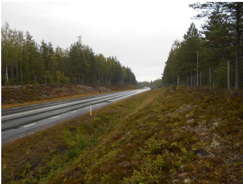
Figur 4.4-1. Vägen vid den föreslagna placeringen av faunabron, vy från söder.
