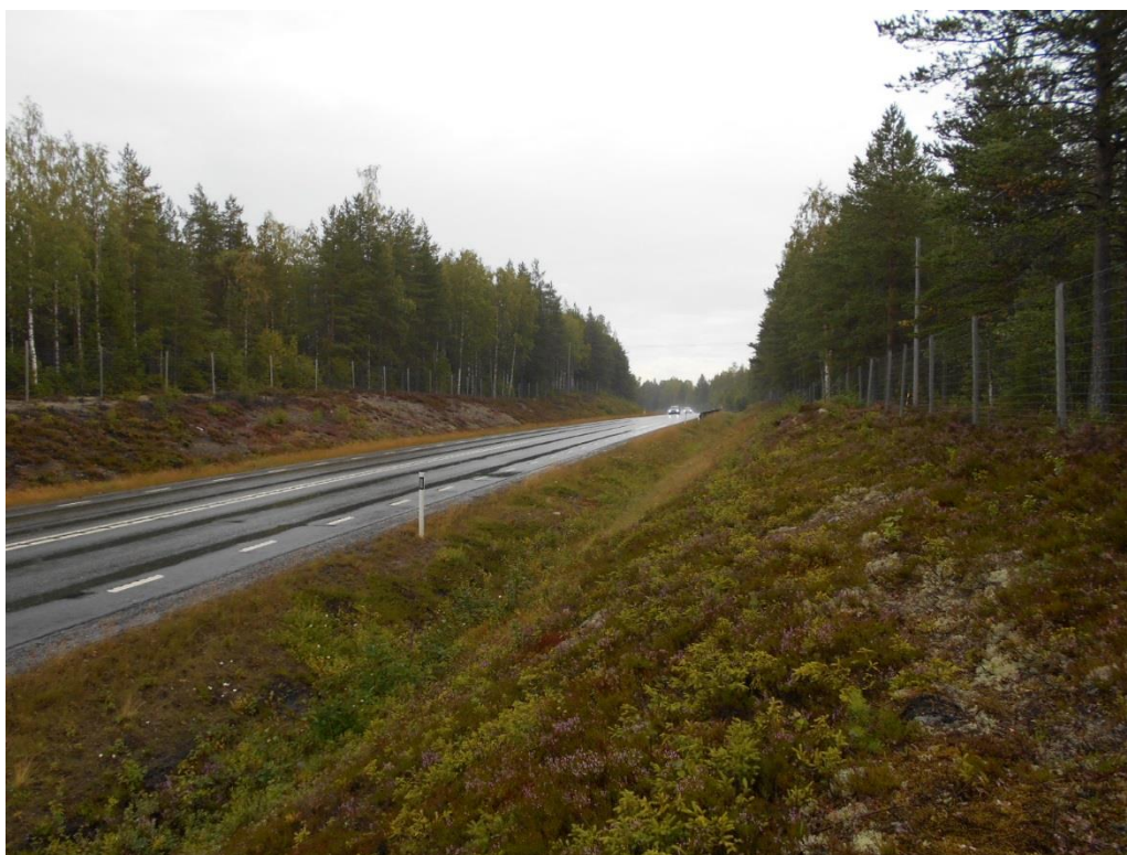
Figur 4.1.6-1. Vägen vid den föreslagna placeringen av faunabron, vy från söder.
