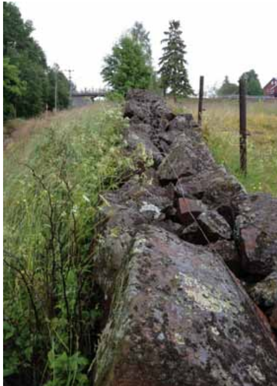
Bild 9.1.3 En äldre stenmur finns kant i kant med betesmark och järnväg. Fotot är taget mot öster, bron kan ses i bakgrunden.
