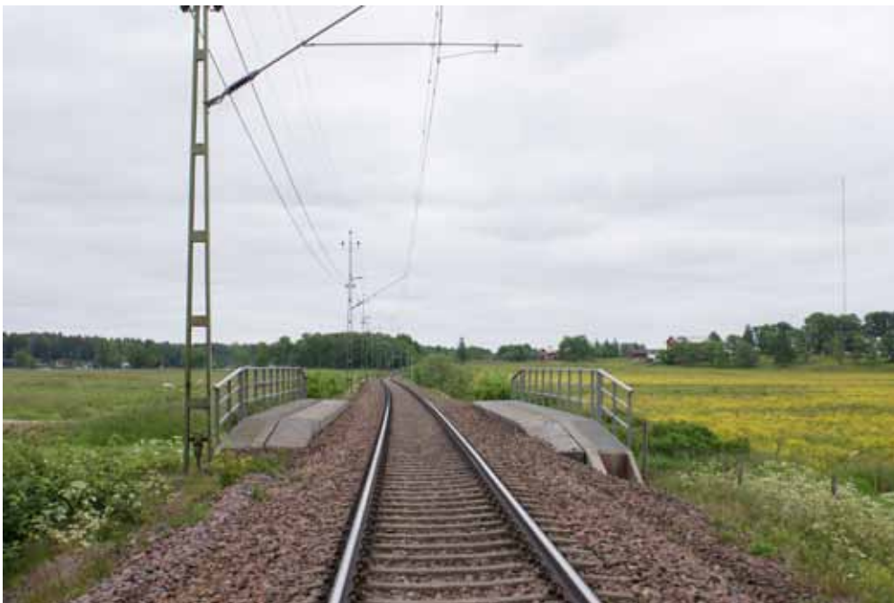
Bild 9.1.1 Storskaligt öppet landskap med bebyggelsegrupper samt landmärke i form av mast sydväst om Ölme samhälle.
