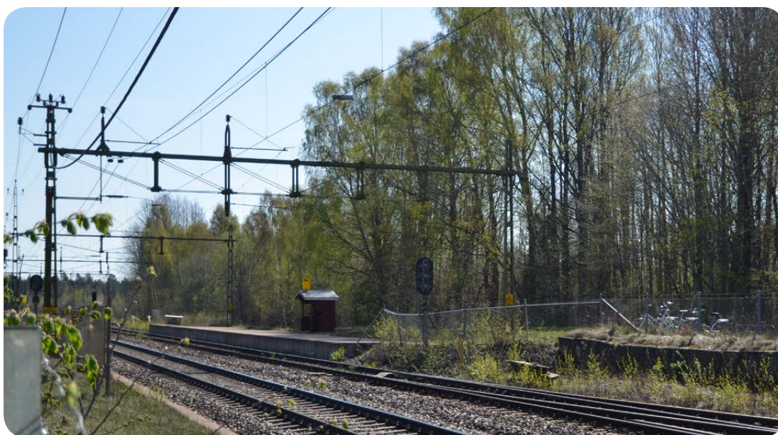
Figur 10 Foto på befintlig plattform i Väse.
