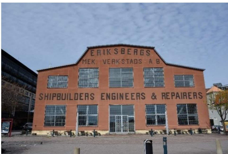
Figur 5.13 Maskinhallen från 1922, numera Eriksbergshallen. Sannegården 28:23 (1).
