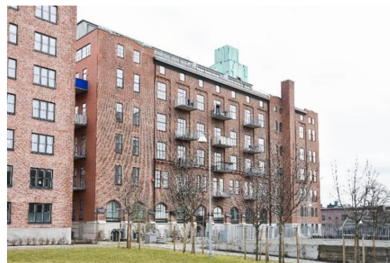
Figur 5.15 Kvarnbyggnaden (Sannegården 7:7) från väster.
