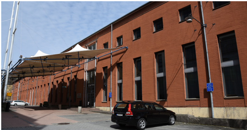
Figur 17. Västra långsidan, Eriksbergshallen.
