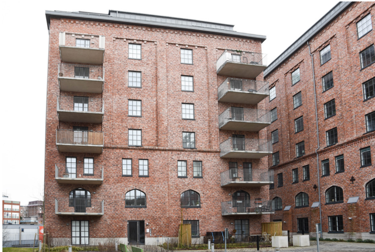
Figur 32. Mjölmagasin 3 från väster (Magasin 1 till höger i bild).
