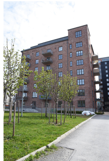
Figur 31. Magasin 1 från väster. Denna del av byggnaden byggdes till 1938 och kallas Paketeringen.
