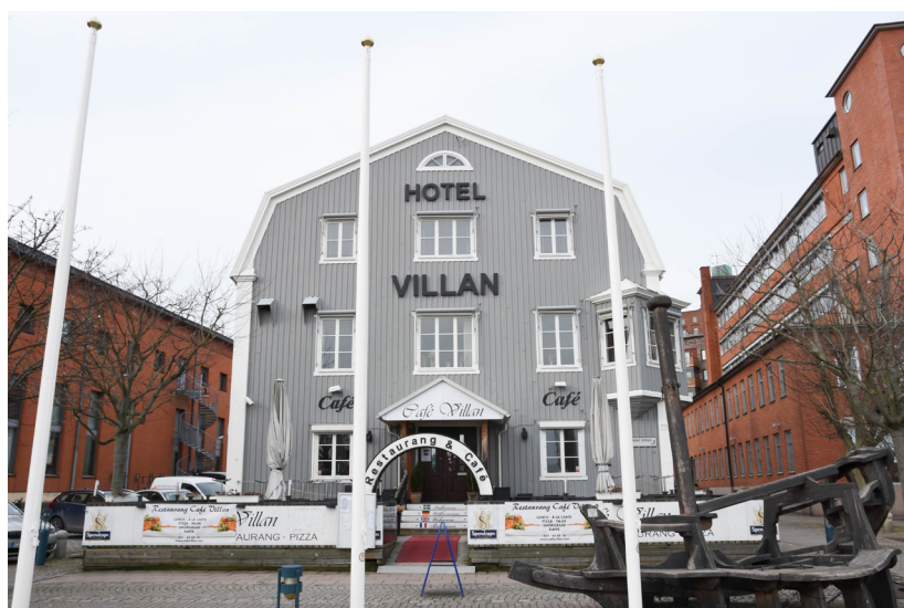
Figur 22. Före detta Huvudkontoret från söder.
