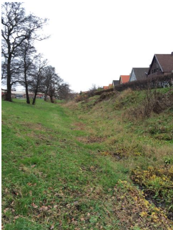
Figur 6.2.3. Gammal bäck som till stor del kulverterades cirka år 1940. En öppen del finns kvar norr om fotbollsplanen och sträcker sig upp till Biskopsgatan där den sedan fortsätter i kulvert.
