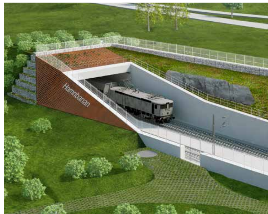
Östra tunnelmynningen. Vy från sydost. Säkerskärmar omgärdar spårområdet.
