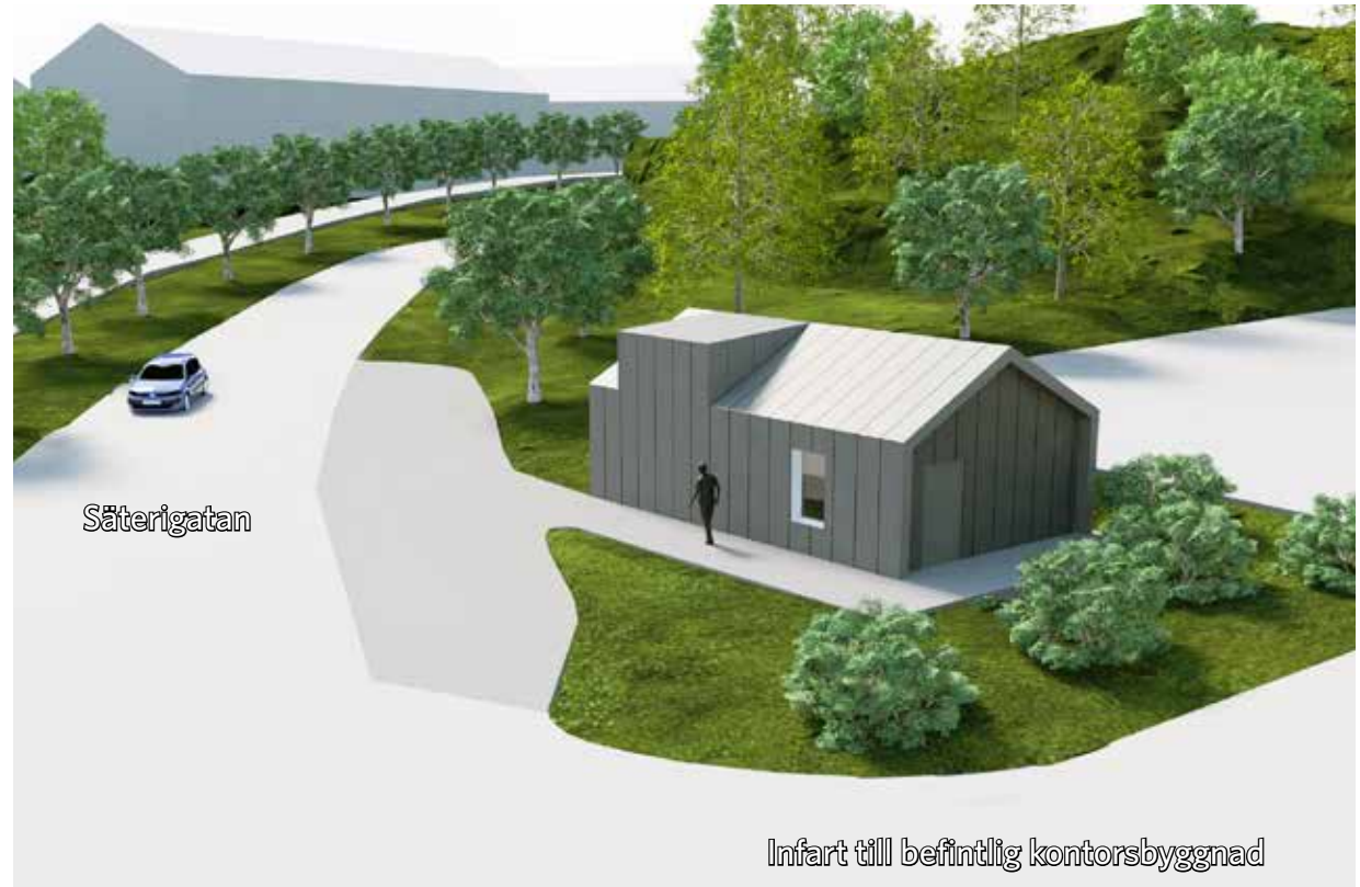
Insatsbyggnad. Vy av sydvästra fasaderna.
