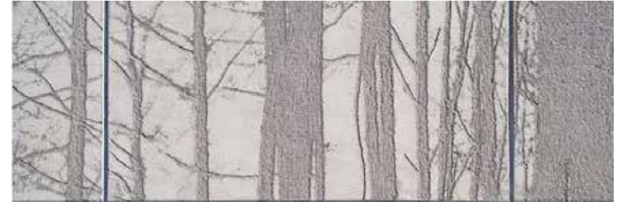
Exempel på konstnärlig ytbehandling av betong
