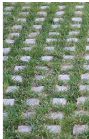
Gräsarmering vid tillfällig plats för fordon.
