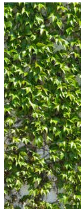
Stödmur av betong med klätterväxt
