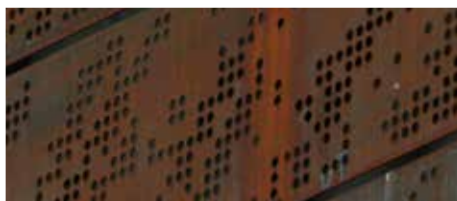
Ytor med perforerad cortenstål där växtlighet kan växa genom.
