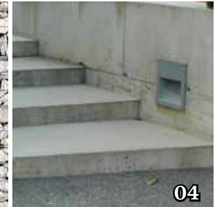
Trappa i betong
