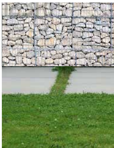
Stödmur av gabion.
