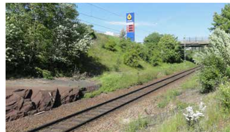
Befintlig situation. Vy nordöst mot bensinmack och Nordviksbron
