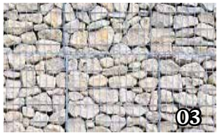
Gabionmur med svetsat nät
