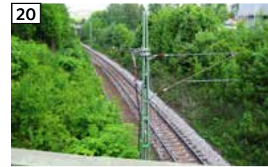
20 Befintlig järnväg, vy från Bratteråsgratan
