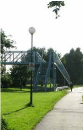
Befintlig belysning på Londongatan
