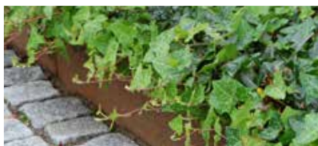
Kantstöd av cortenstål håller formen på planteringar
