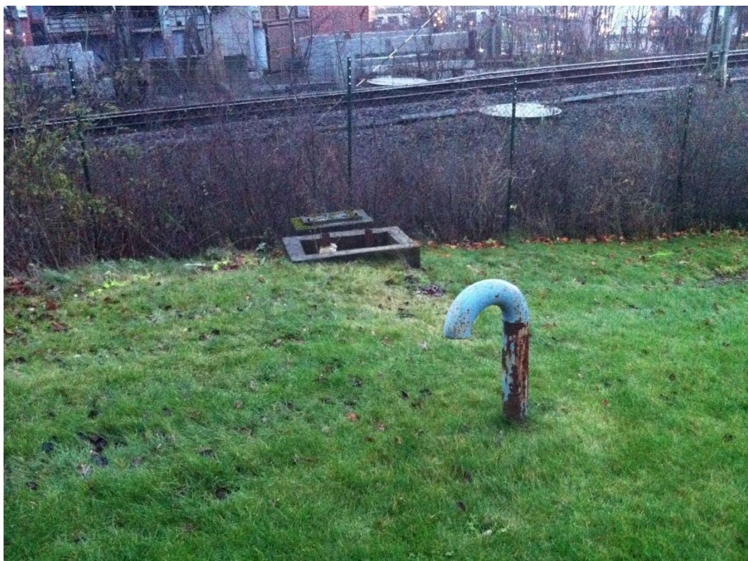
Figur 2-3; Foto, befintlig betongbrunn och rör.
