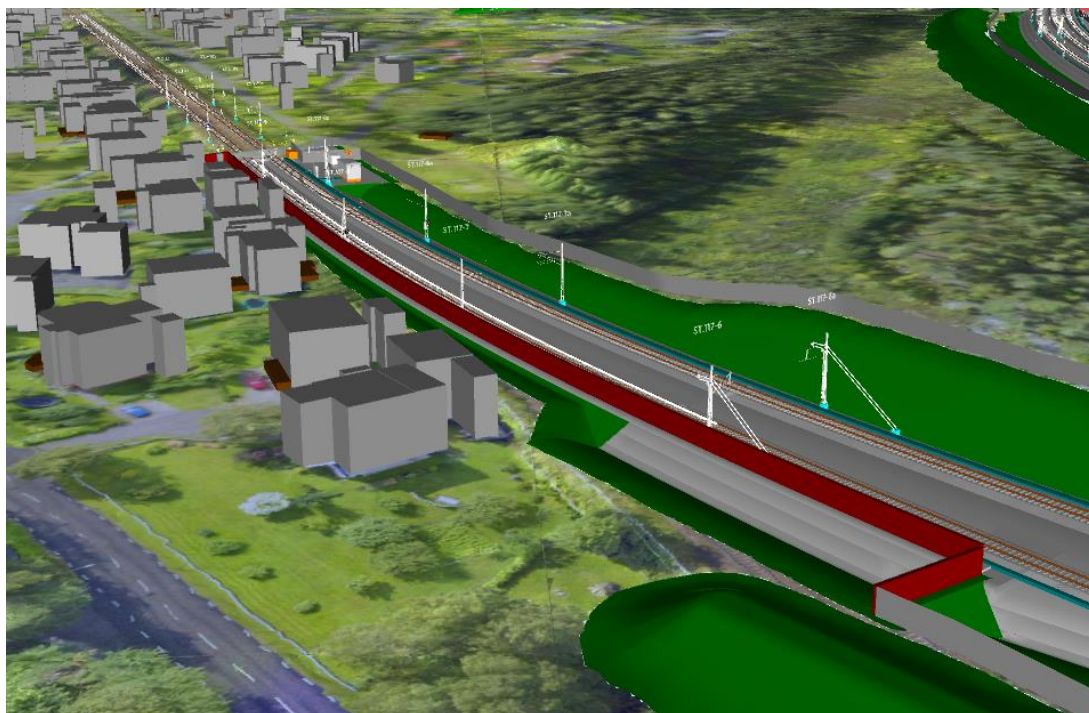
Figur 27. Vy mot norr i Lexe. Korsningen med Centralvägen, järnvägsplanens slutpunkt, till vänster. Färgerna i illustrationen motsvarar inte den färdiga anläggningen. Figur hämtad ur: samordningsmodell, version 30 november 2023.
