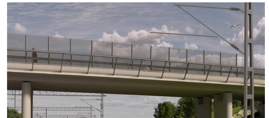
Figur 43. Illustration av genomsiktig elskyddsanordning.
