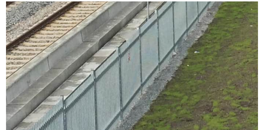
Figur 27. Exempel på palissadstängsel. Observera dock att palissadstängsel i projektet ska vara mörkgrått.
