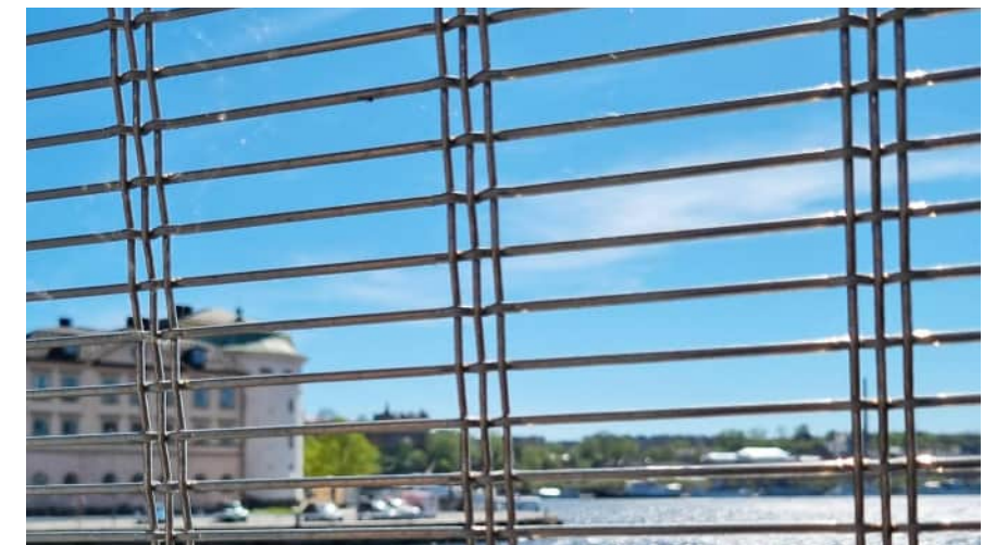
Figur 52. Inspirationsbild som visar exempel på stålnät som genomsiktig del i broräcke.
