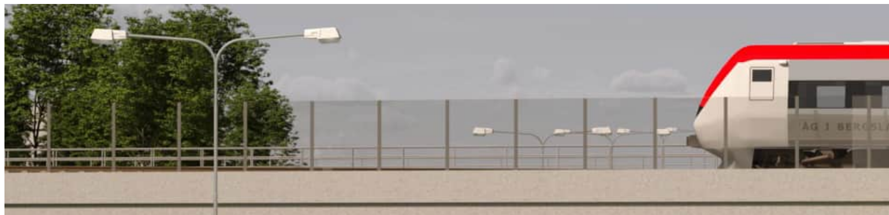
Figur 32. Illustration av genomsiktig bullerskyddsskärm på bro.
