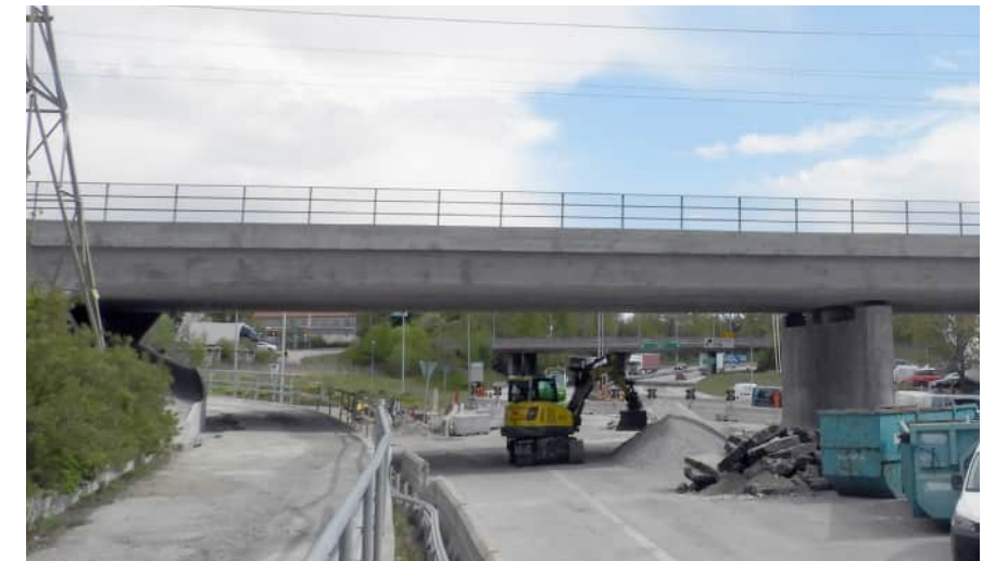
Figur 16. Inspirationsbild på järnvägsbro med rundad undersida, framträdande kantbalk och skivstöd med rundad kortsida.
