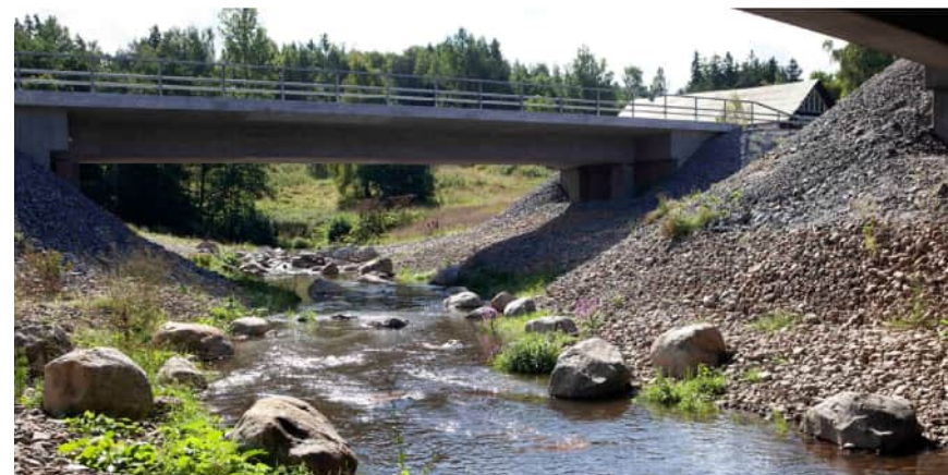
Figur 45. Exempel på vattendrag med konstgjord åfåra under väg 73. Här hade det varit önskvärt att täcka makadamlänterna med jord. Foto: Trafikverket.
