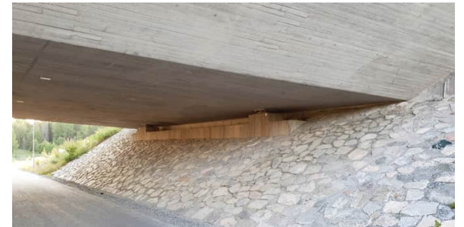
Figur 20. Exempel på ordnad stensättning i slänt under bro.
