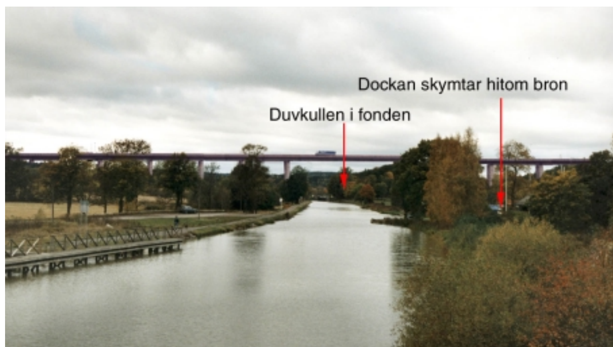
Den nya kanalbron sedd från den befintliga klaffbron
