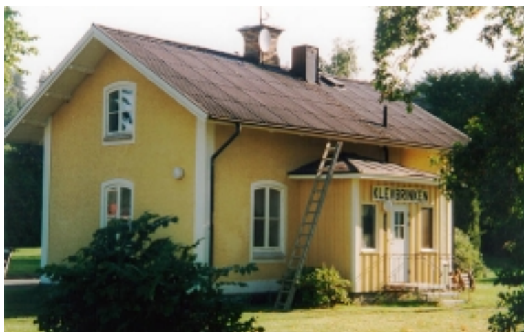
Brovaktarbostaden kan tillfälligt flyttas under byggtiden
