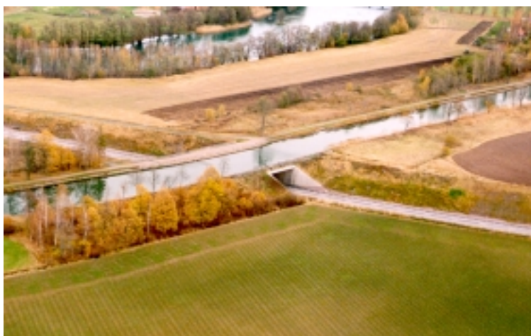
Bild på akvedukten i Borensberg, en av Göta kanals två akvedukter. Den andra finns i Ljungsbro.
