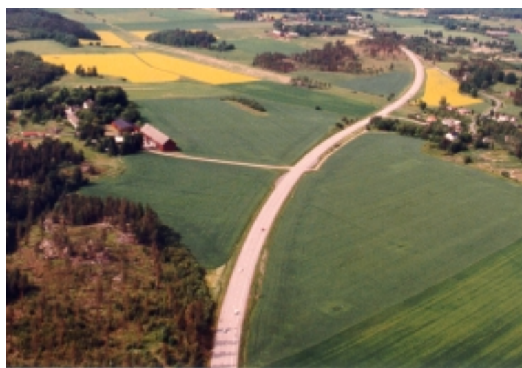
Del 1 Braberg - Väg 210
