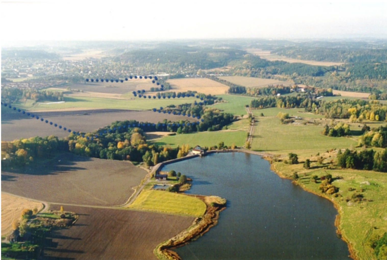
Från Strodammen tas råvatten som infiltreras i åsen på andra sidan Tvärån i bild. Mot öster utgör ån gräns för vattentäktens yttre skyddsområdesområde som är markerat i bilden. En ny väg i alt. Öst förutsätts passera mellan skyddsområdet och i kanten av eller över
