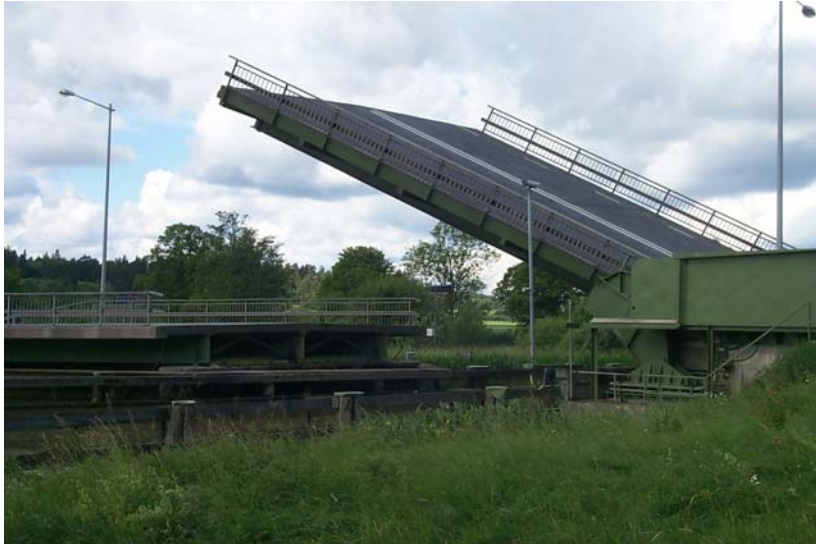
Fig: Befintlig öppningsbar bro över Göta Kanal
