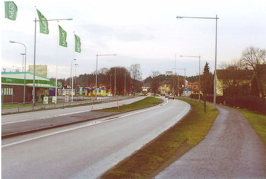
Fig: Nuvarande väg E22 genom Söderköping
