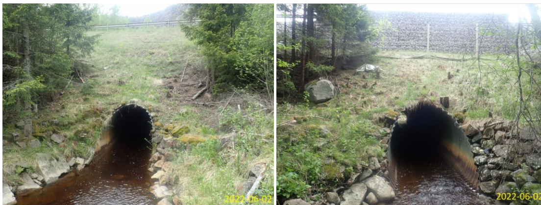
Figur 5. Bilderna visar Veån och rörbron i riktning västerut (vänstra bilden) och riktning österut (högra bilden)
