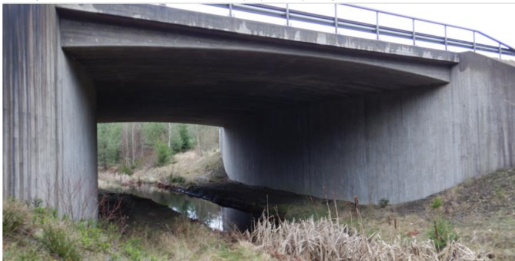
Figur 15. Ett exempel på en faunaport, en passage under vägen där djur kan passera.
