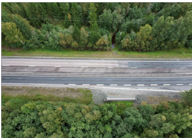
Figur 4. Bilden visar anläggningen ovanifrån. Gabionmuren syns längst ner i bild.
