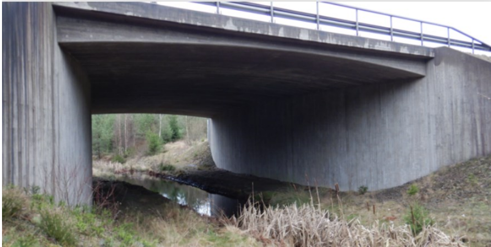
Exempel på en faunaport, en passage under vägen.
