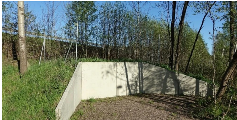
Exempel på ett viltuthopp med sand nedanför, där älgar och andra djur som kommit in på vägbanan kan hoppa ut. Fallhöjden är tillräckligt hög för att hindra djur att ta sig in på vägbanan. Viltstängsel ansluter mot uthoppet.
