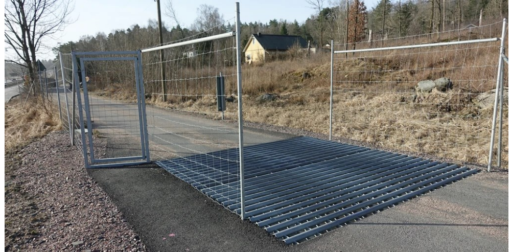
Exempel på en färisk, ett galler som hindrar djur att passera.
