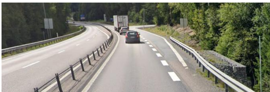
Figur 6. Vy över E4 söderut från bron över Veån. På bildens högra sida ses stödmur på bron västra sida. Ett högeravsvängkörfält löper från bron fram till infartsvägen in mot Naturum. Bildkälla: Google Earth.
