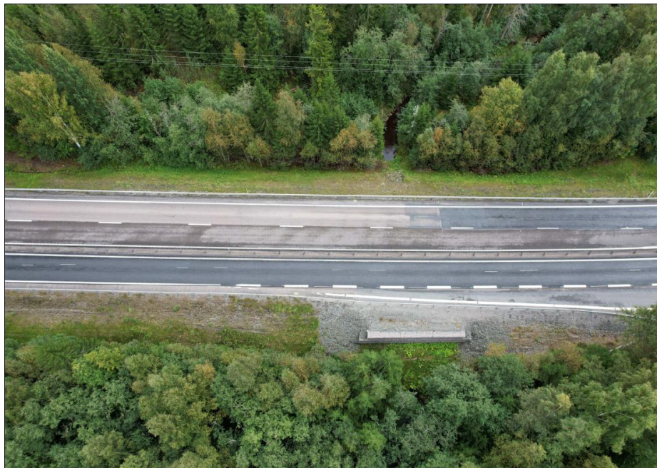
Figur 10. Bilden visar anläggningen ovanifrån. Gabionmuren syns i nedre delen av bilden, mellan vägen och träden. Norr är till vänster i bild (drönarfoto, Trafikverket 2025).
