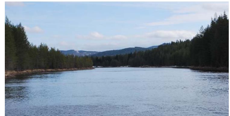
Österdalälven öster om befintligt brolägg, med skogsklädda stränder och den storkuperade terrängen i bakgrunden.
