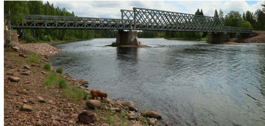
Den nya ersättningsbron på befintliga brostöd.
