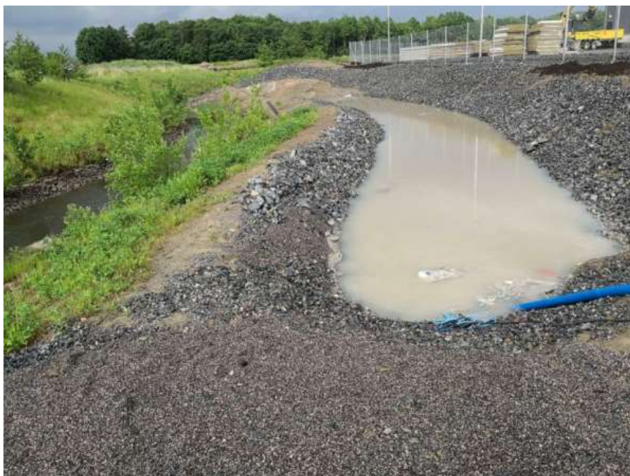
Figur 20. Exempel på möjlig tillfällig damm (Källa foto: Swedish Hydro Solutions, 2021).
