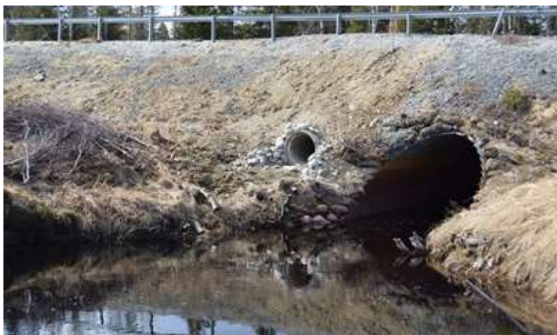
Figur 13. Torrtrumma vid vattendrag. Bild hämtad från Temablad Natur "Faunapassager för utter och medelstora däggdjur".
