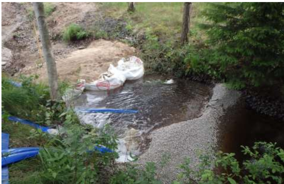
Figur 17. Exempel på skyddsåtgärd med en genomsläpplig barriär. Vatten pumpas förbi arbetsområdet. (Källa foto: Trafikverket, Agne Gunnarsson).
