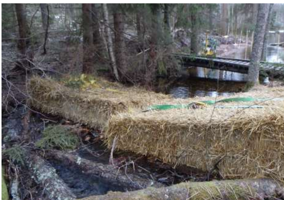
Figur 19. Exempel där halmbalar lagts ut för att dämna vattenflödet och samla upp sediment vid arbetet i vattenområden (Källa foto: Trafikverket (Agne Gunnarsson)).
