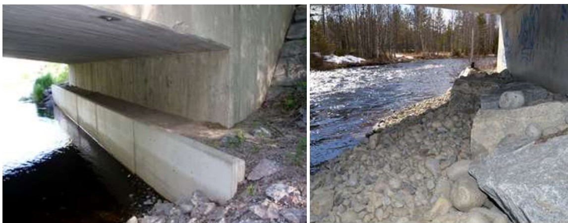
Figur 12. Strandpassage med betongstöd (vänster) respektive stenblock (höger). Bild hämtad från Temablad Natur "Faunapassager för utter och medelstora däggdjur".
