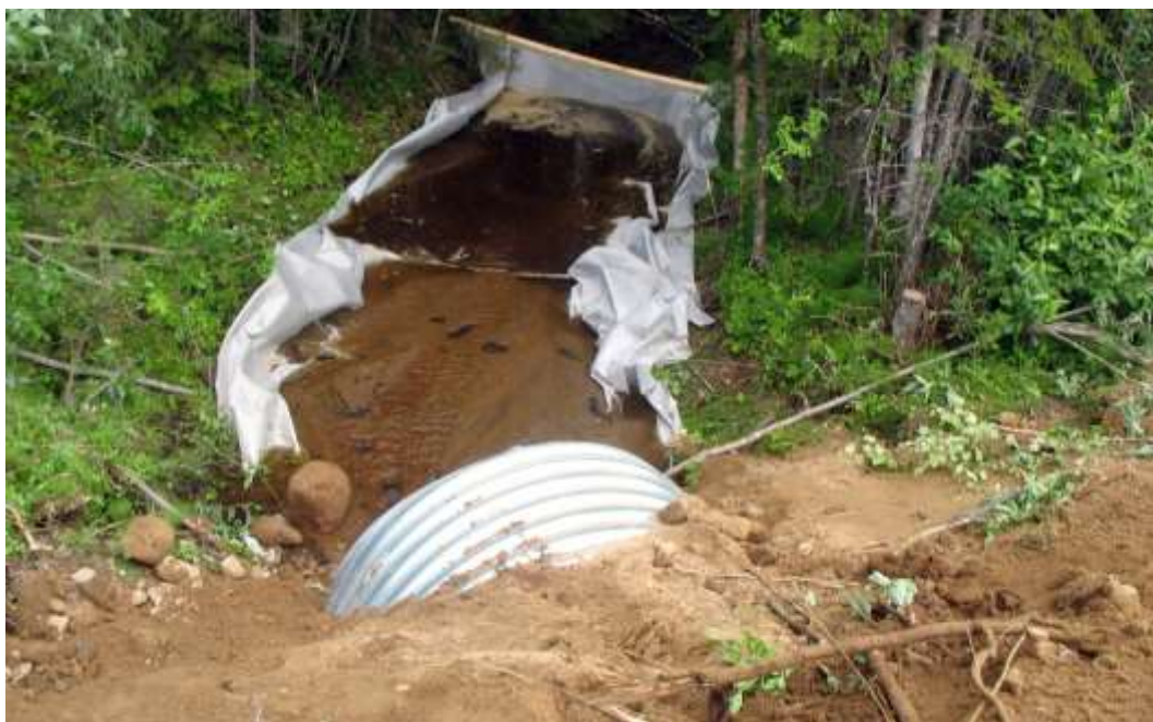
Figur 18. Exempel där geotextil lagts ut för att samla upp sediment vid anläggande av trumma (Källa foto: Trafikverket 2014).
