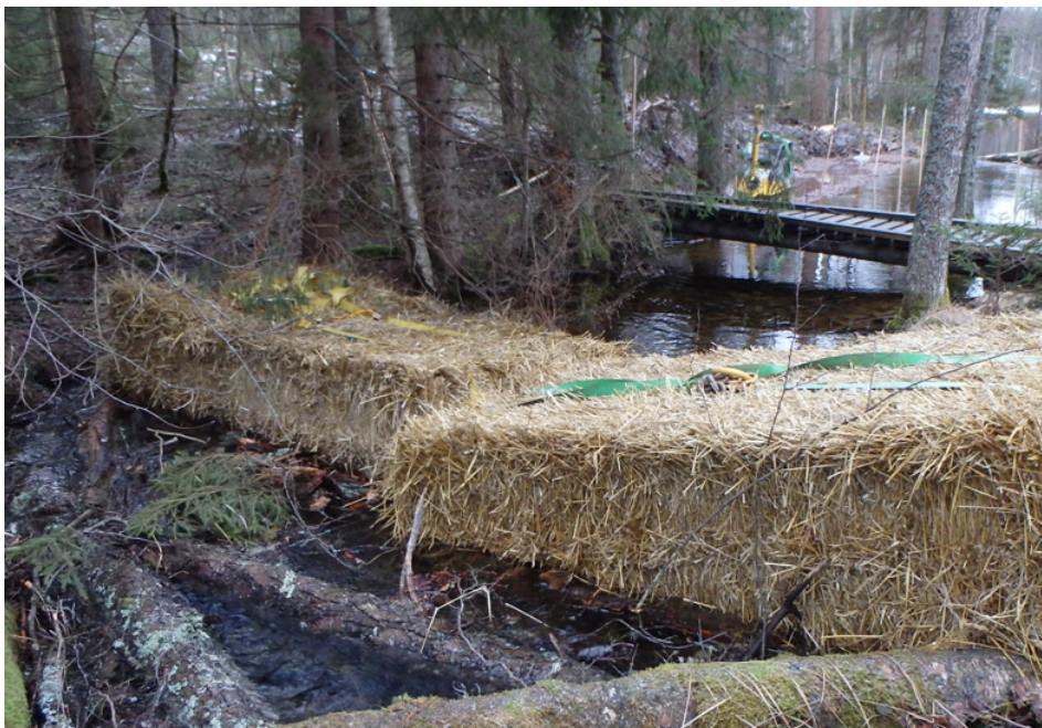
Figur 21. Exempel där halmbalar lagts ut för att dämna vattenflödet och samla upp sediment vid arbetet i vattenområden (källa foto: Trafikverket, Agne Gunnarsson).
