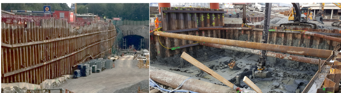
Figur 16. Till vänster bakåtförankrad stålspont. Till höger stämpad stålspont.
