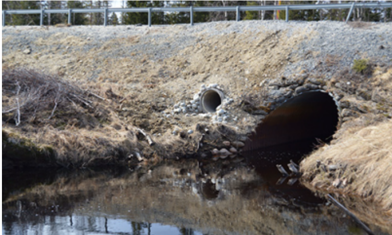
Figur 14. Torrtrumma vid vattendrag. Bild hämtad från Temablad Natur "Faunapassager för utter och medelstora däggdjur".
