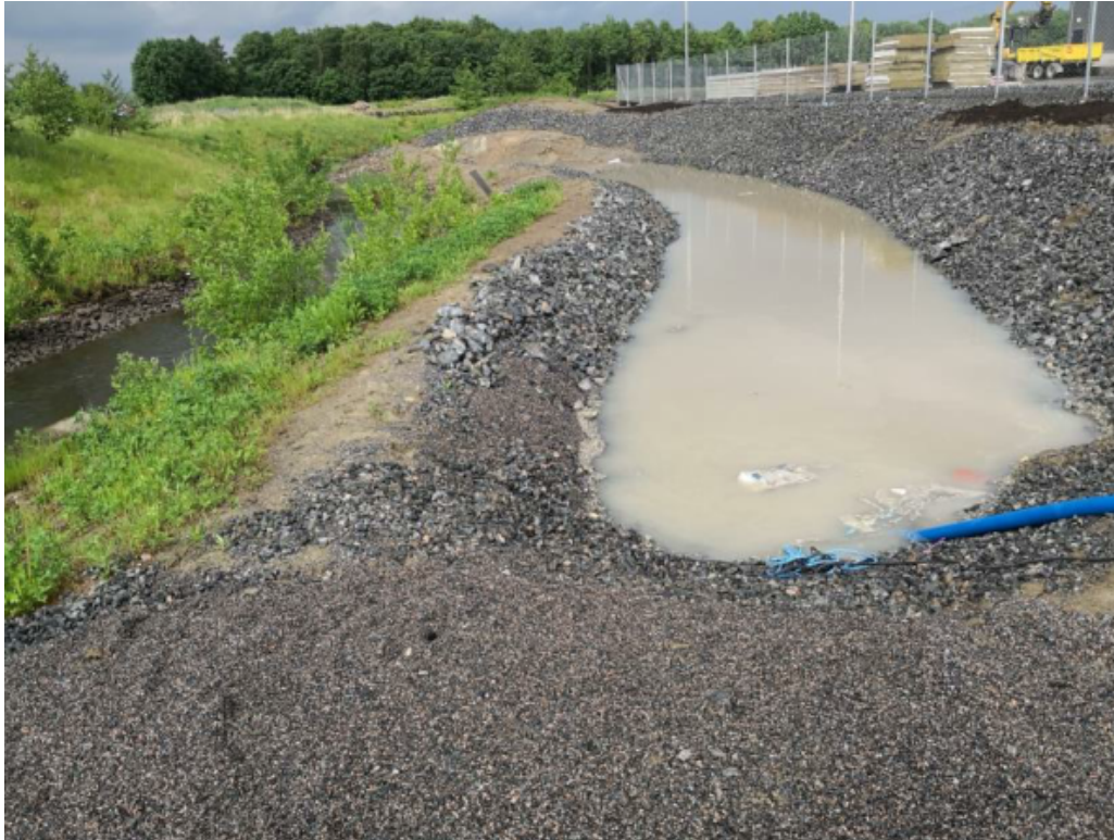
Figur 22. Exempel på tillfällig damm (källa: Swedish hydro solutions. 2021).
