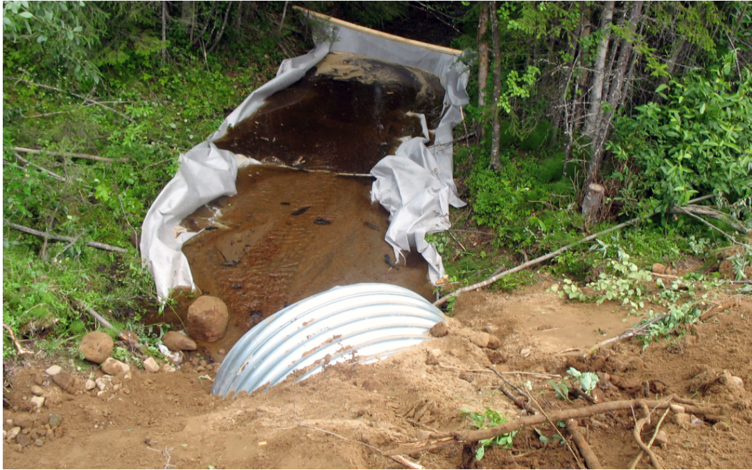
Figur 20. Exempel där geotextil har lagts ut för att samla upp sediment vid anläggande av trumma. (Källa: Trafikverket 2014)
