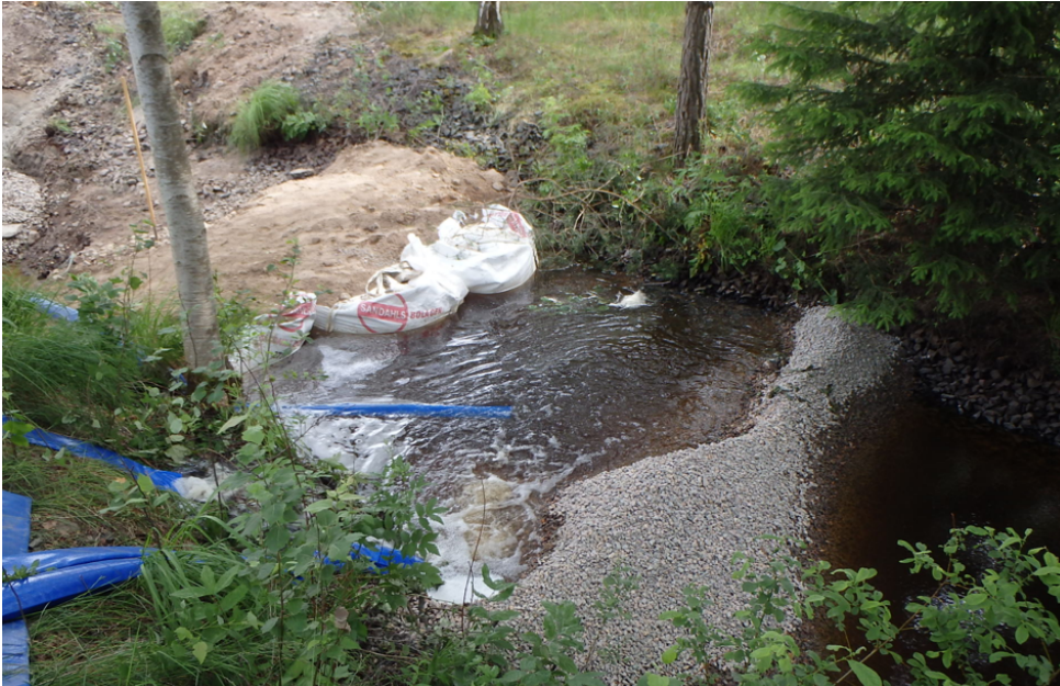
Figur 19. Exempel på skyddsåtgärd med en genomsläpplig barriär. Vatten pumpas förbi arbetsområdet. (källa foto: Trafikverket, Agne Gunnarsson).
