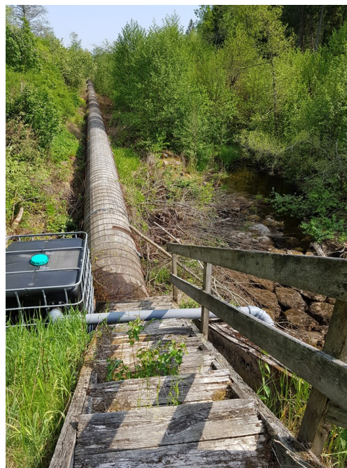
Figur 19 Vänstra bilden visar Ålbergaåns vattenåfåra och högra bilden visar kraftverkstrumman.
