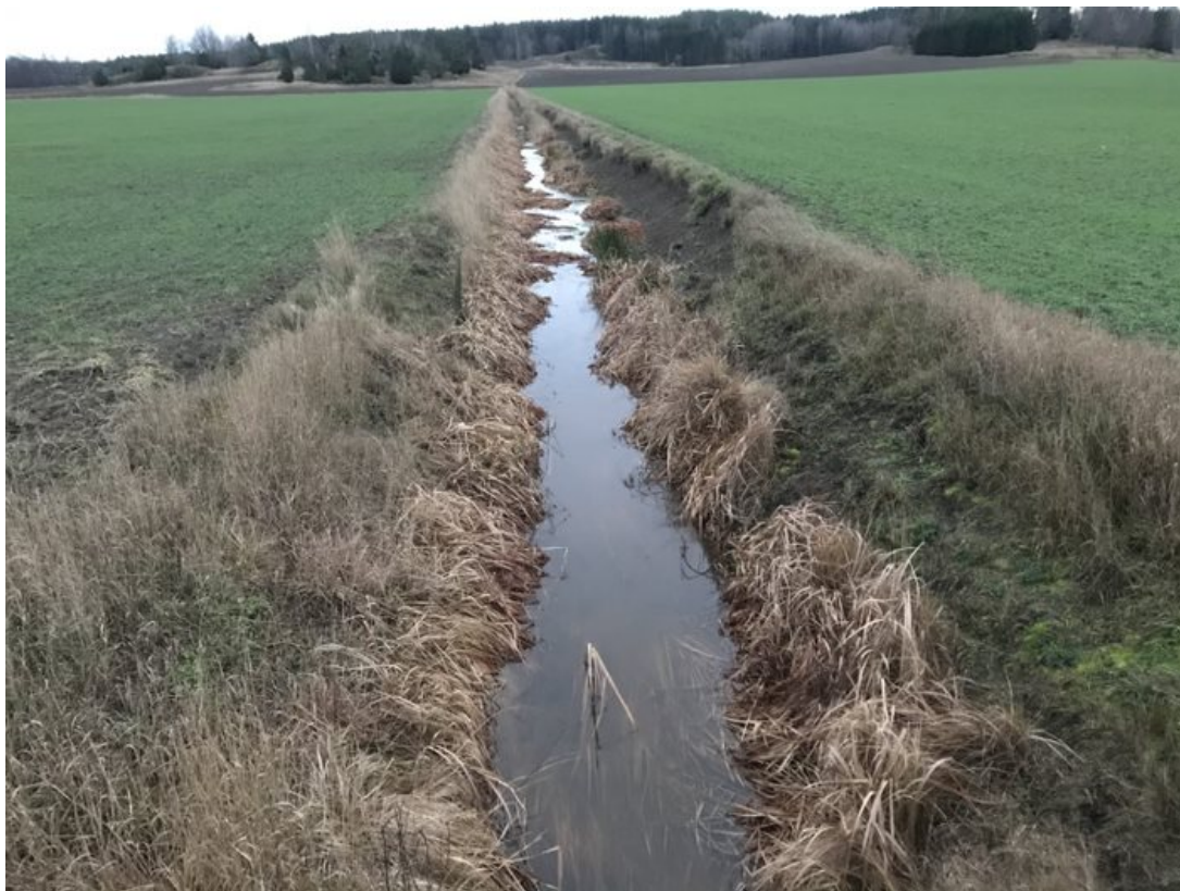
Figur 16 Dike vid Ingemundsta inom Marå-Gärdesta torrlägningsföretag 1945 (ID 397).
