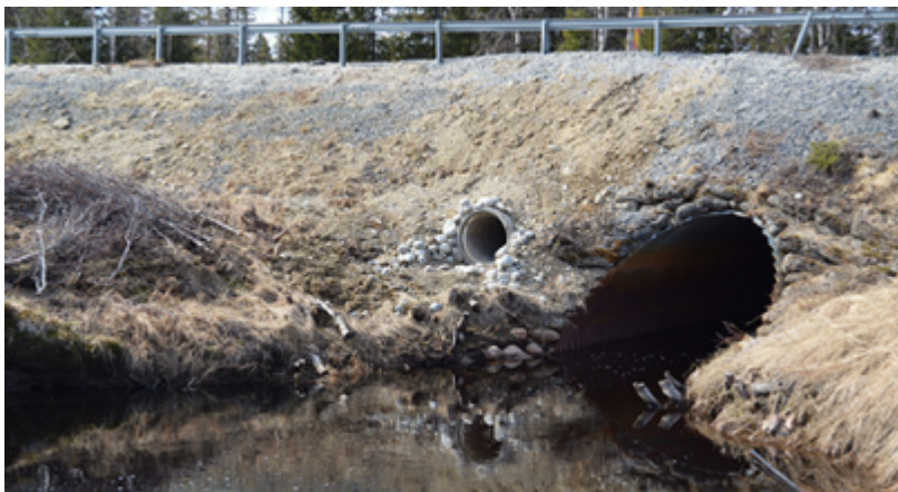
Figur 16. Torrtrumma vid vattendrag. Bild hämtad från Temablad Natur "Faunapassager för utter och medelstora däggdjur".
