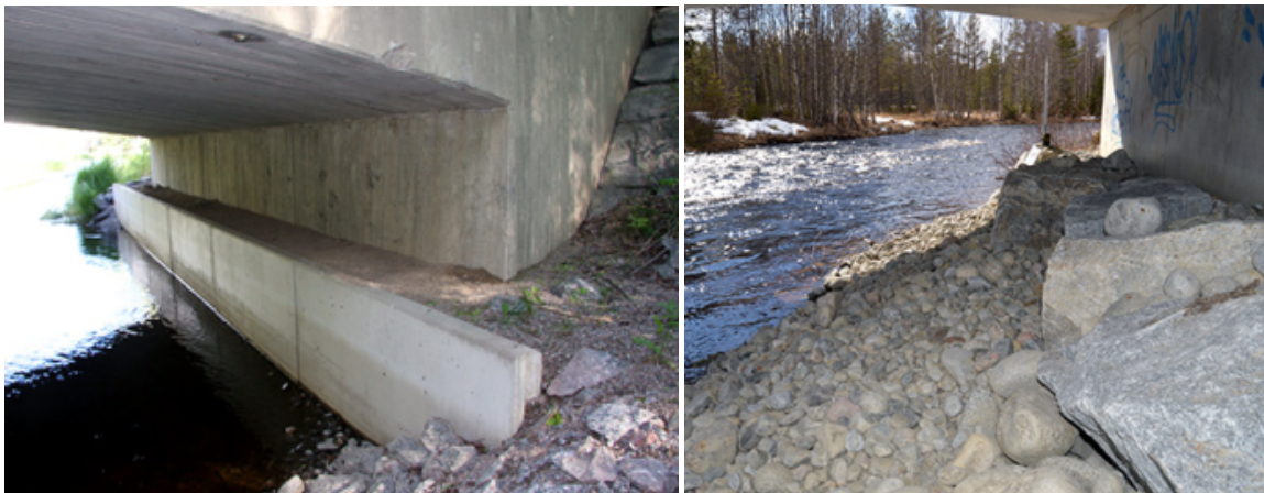
Figur 15. Strandpassage med betongstöd (vå) respektive stenblock (hö). Bild hämtad från Temablad Natur "Faunapassager för utter och medelstora däggdjur".
