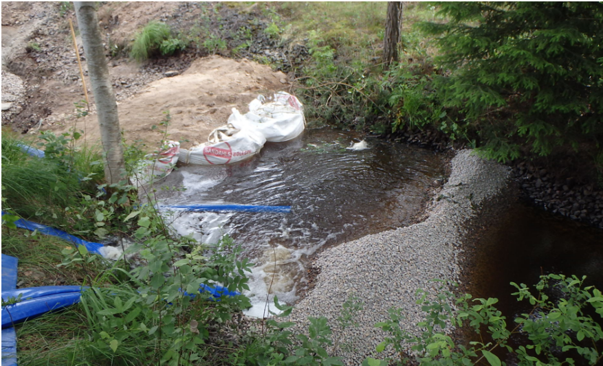
Figur 20. Exempel på skyddsåtgärd med en genomsläpplig barriär. Vatten pumpas förbi arbetsområdet. (Källa foto: Trafikverket, Agne Gunnarsson.)
