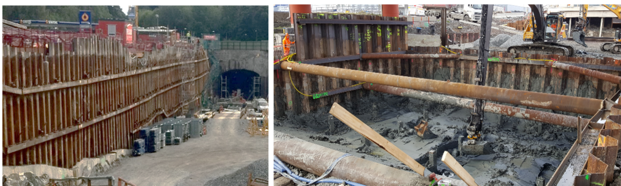
Figur 18: T.v. bakåtförankrad tätspont. T.h. stämpad stålspont.
