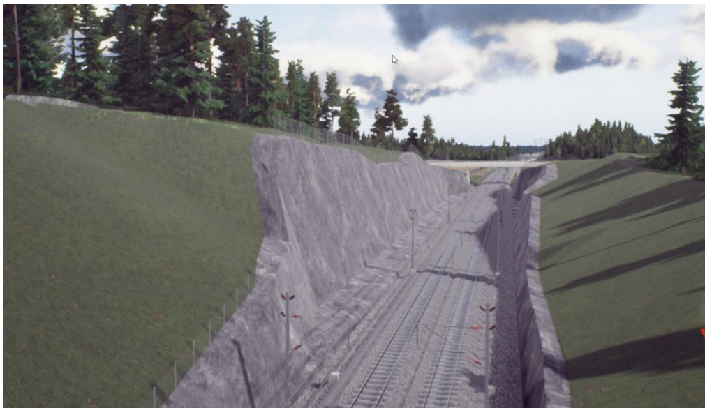
Figur 16. Illustration av skärningen inom Tystberga vattenskyddsområde vid km 39+700. Vy mot nordöst och vägbron för väg 771.
