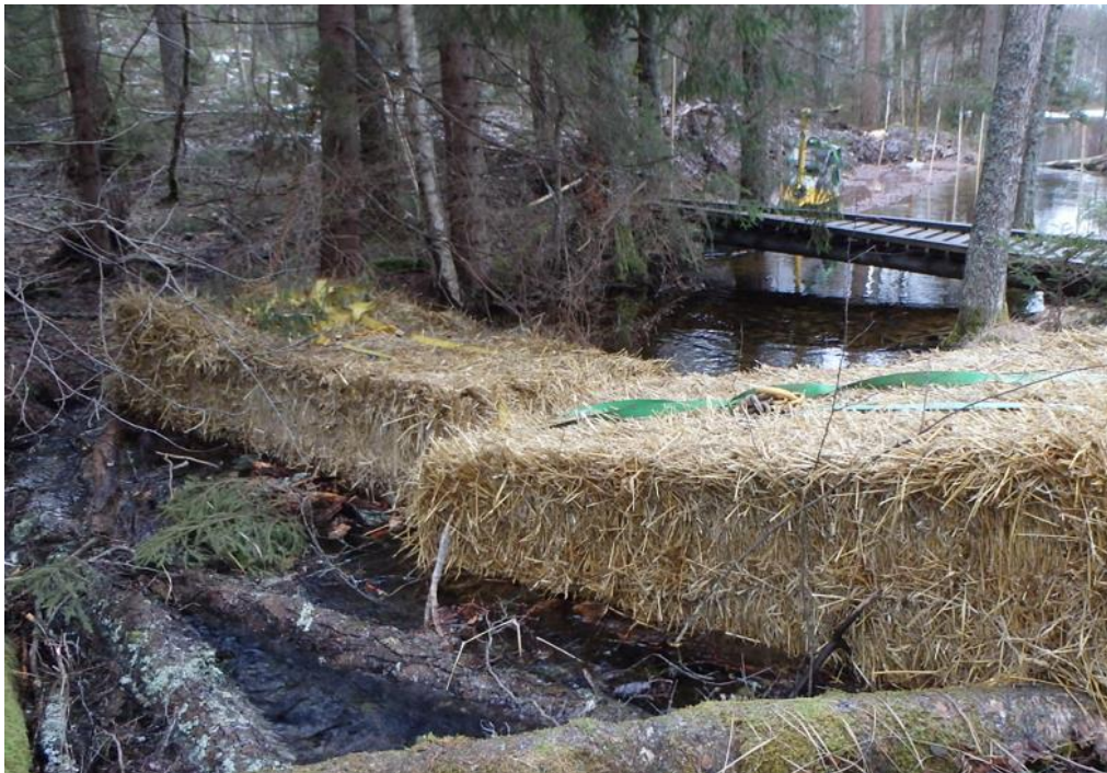
Figur 27. Exempel där halmbalar lagts ut för att dämna vattenflödet och samla upp sediment vid arbetet i vattenområden (källa foto: Trafikverket, Agne Gunnarsson).
