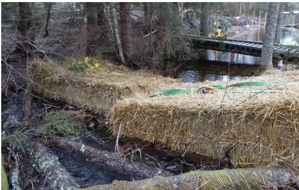
Figur 44. Exempel där halmbalar lagts ut för att dämna vattenflödet och samla upp sediment vid arbetet i vattenområden (källa foto: Trafikverket, Agne Gunnarsson).
