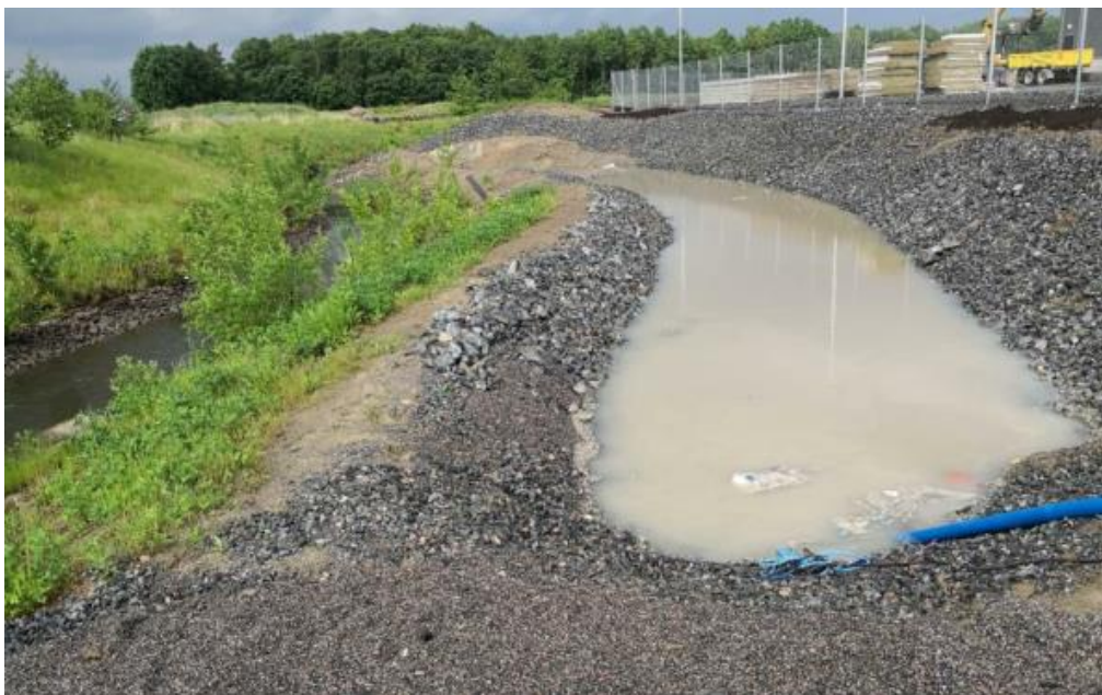
Figur 17. Exempel på tillfällig damm (källa: Swedish hydro solutions. 2021).
