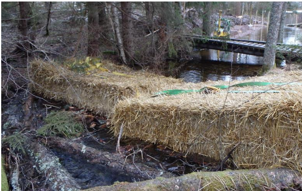
Figur 16. Exempel där halmbalar lagts ut för att dämna vattenflödet och samla upp sediment vid arbetet i vattenområden (källa foto: Trafikverket, Agne Gunnarsson).
