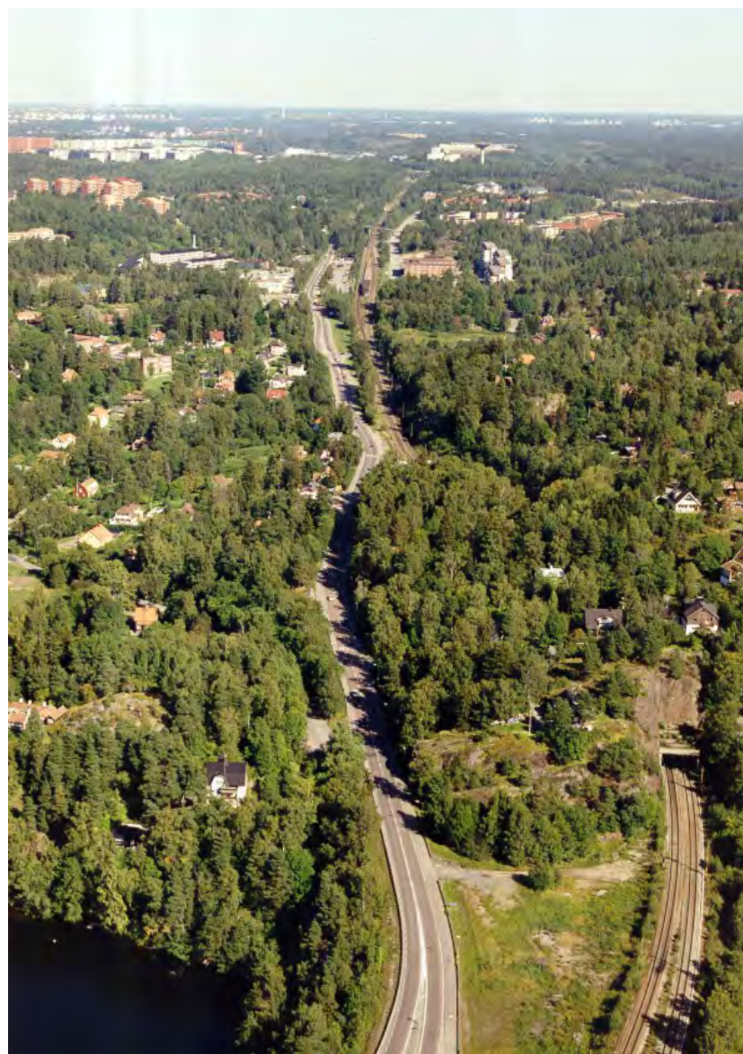
Breddning till fyra körfält inför ett storskaligt element i landskapet. Vy mot öster och Tullinge centrum
