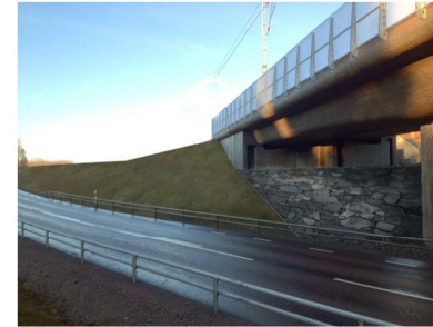
Exempel på ett välutformat möte vid landfäste Källa Trafikverket
