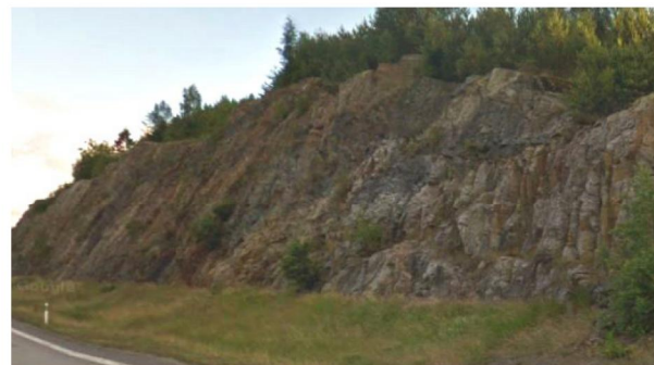
Exempel på varierad bergsprängning
