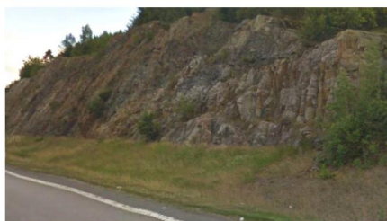
Foto som visar exempel på varierad sprängning av berg. Naturliga sprickor rensas, bergskrönet skalas av från vegetation och avrundas. Naturlig förna och växtrester tillåts etablera sig längs bergsidan.
