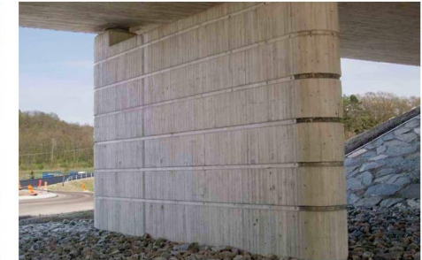
Enkel men effektiv relief på pelarskvist Källa Trafikverket
