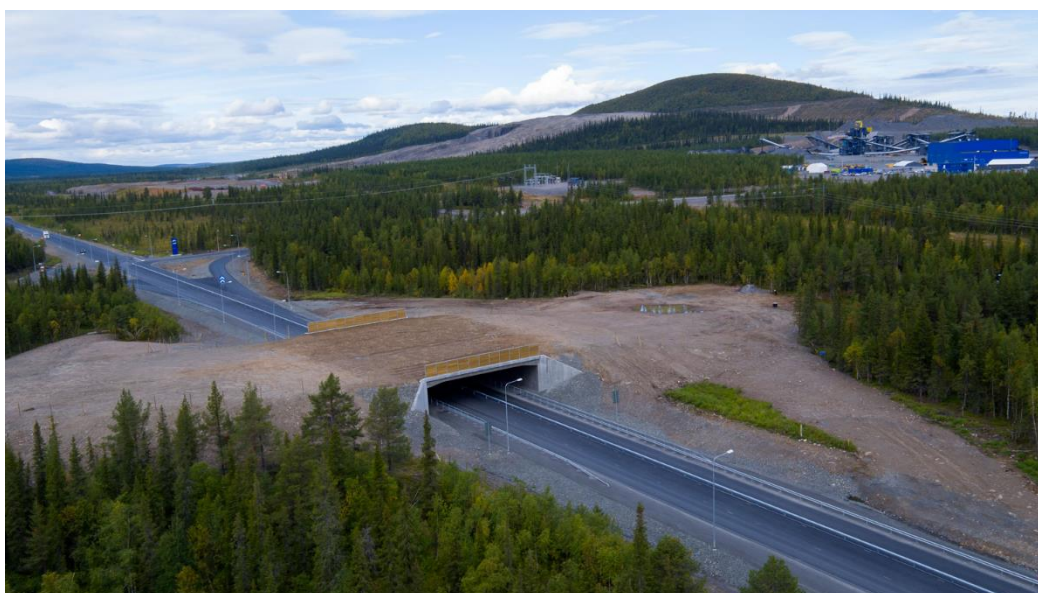
Figur 15. Exempel på en planskild faunapassage. Bilden visar en 50 m bred faunabro över E10 Svappavaara (foto från BatMan).
