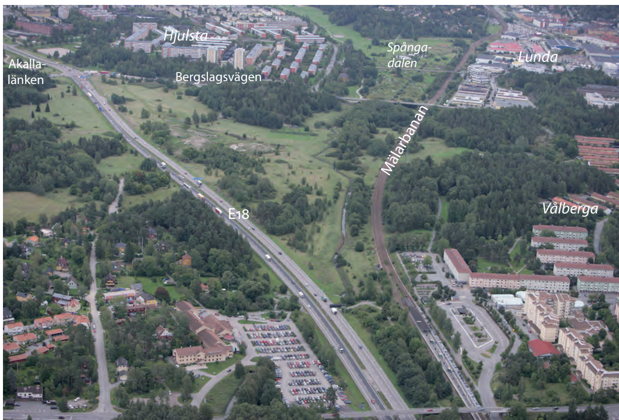
Figur 4.5 Trafikplats Hjulsta sett ifrån Barkarby i nordväst
