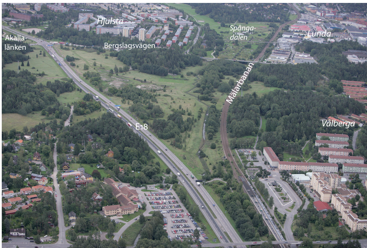
Figur 4.5 Trafikplats Hjulsta sett ifrån Barkarby i nordväst
