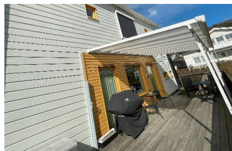
Figur 2. Uteplats södra delen
