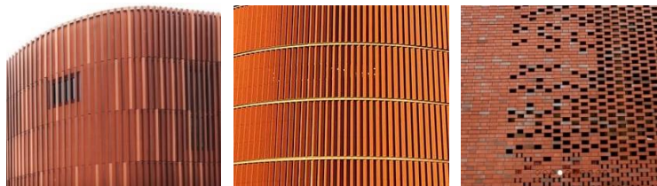
Figur 34 Under broarna behöver ytskiktet både bidra till en trygg och omhändertagen miljö samtidigt som materialet ska kunna vara bullerdämpande. Ett exempel på detta är skärmtegel (de två första bilderna) eller som traditionellt tegel med en stor andel hål och bullerdämpning innanför (den sista bilden). Källa: https://www.bkr.se och https://www.byggfaktadocu.se
