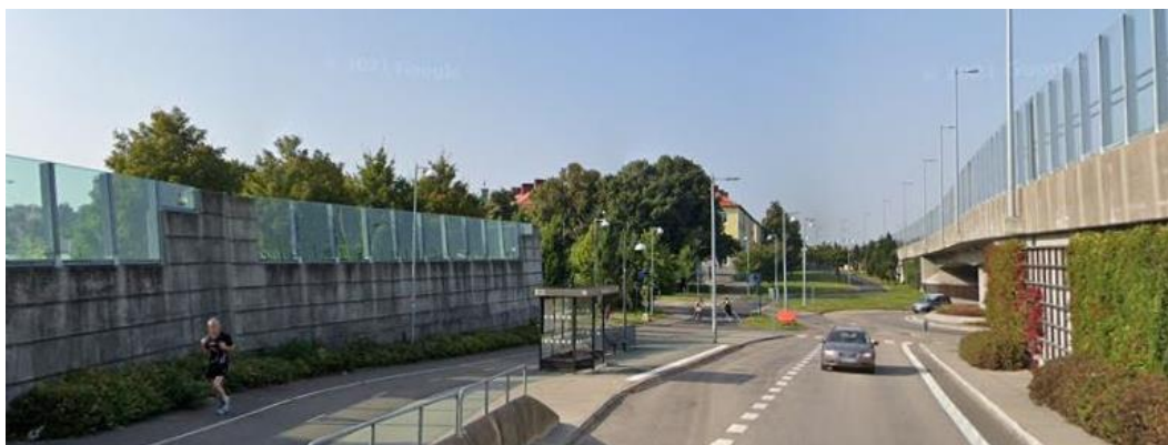
Figur 32 Infrastrukturens stödmurar behöver en omsorgsfull detaljutformning för ett positivt bidrag till stadsmiljön. Ovan ett exempel från Gamlestadens där mönster och vegetation utnyttjas för att mildra murarnas monumentalitet. Bilden visar även att betongmurar som ligger i fel väderstreck kan utsättas för algpåväxt från regnvatten vilket behöver beaktas vid val av ytskikt. Källa: Google maps ©2022 Google.
