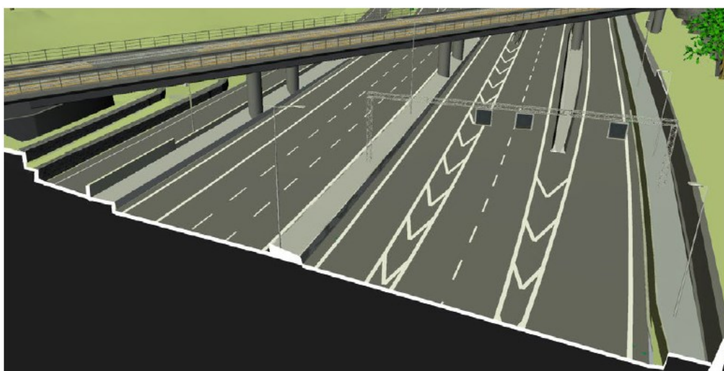
Figur 31 Mittbarriär och stödmurar med terrasser under Bohusbanan.
