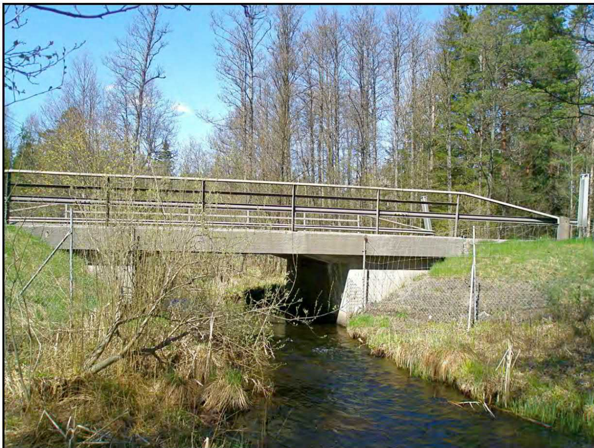
Foto 7.9.1.22. Vägbron vid Allmänningsån.
