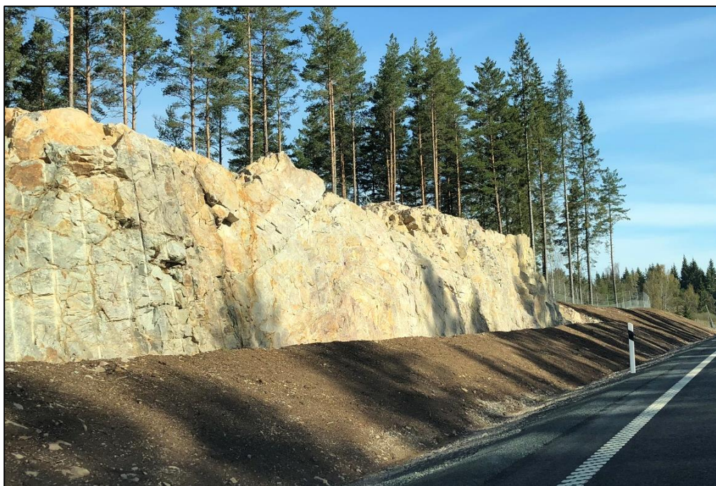
Exempel på bergskärning som är belägen strax norr om Blå Grindar längs väg 32. Motsvarande utförande är tänkt vid bergskärningarna mellan Vinkan och Rosan.
