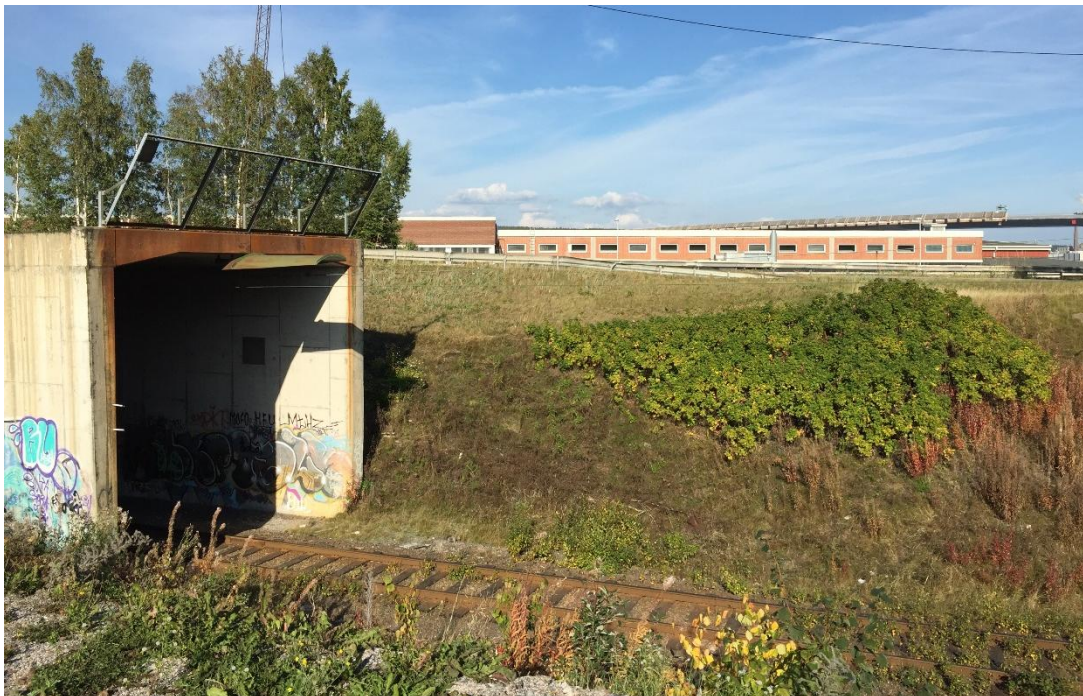
Figur 2.5 Ett industrispår passerar i tunnel under väg 562 vid projektets slut i norr. Spåret ska eventuellt flyttas. I bakgrunden skymtar byggnader från Södra kajen, samt Sundsvallsbron.
