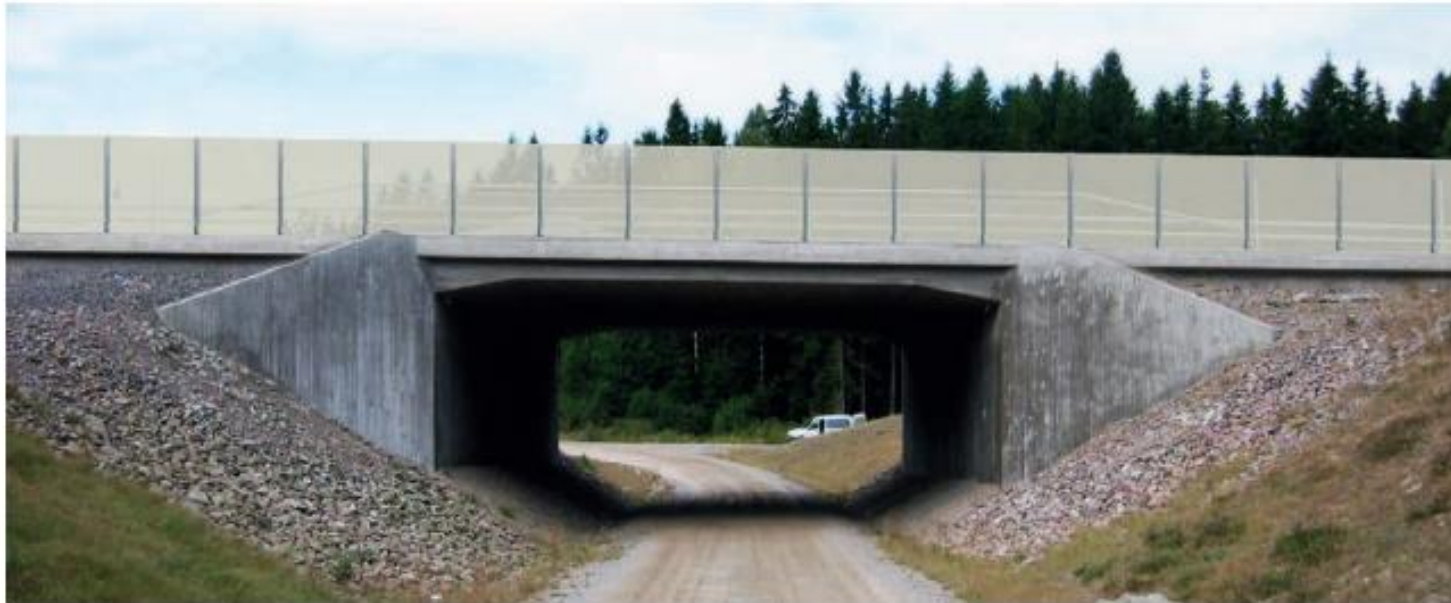
Figur 7 Illustration av tänkbar lösning med siktskärm på befintlig port. Siktskärmerna skall dock inte vara transparent som i denna illustration ovan. Illustration Enviroplanning AB
