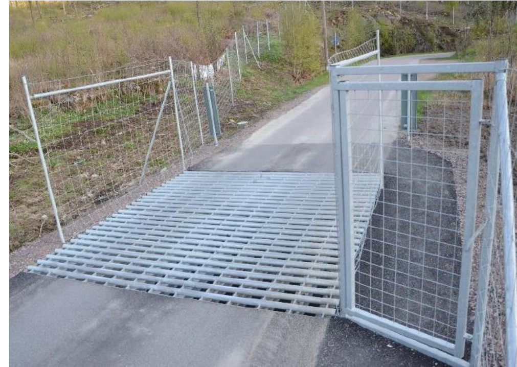
Figur 6 Färist används i stängselöppningar på enskilda Vägar för att förhindra att djur tar sig in på vägområdet. Här en färister över en enskild väg kombinerad med grind. Färisten kan bestå av ett gallersystem som framför allt klövdjur undviker att gå över.
