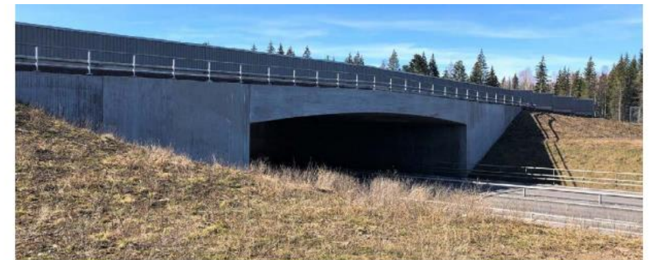
Foto: Faunabro vid Hova på E20, exempel på rambro i betong.
