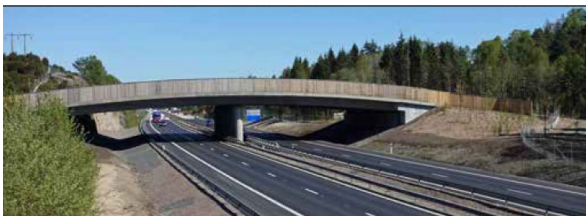
Figur 36. Faunaskärm, kantbalkar och öppenhet under bron är faktorer som påverkar trafikantens upplevelse av faunabron. Foto från Ekodukt Sandsjöbacka.
