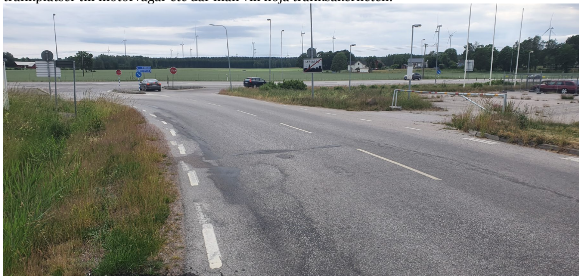
Figur 17. Korsning vid Lyrestad. Nuvarande viltstängsel fortsätter förbi platsen enbart på södra sidan E20. Stängselkorrigering och färäst föreslås på plats. Se figur 18, föreslagen nydragning av viltstängsel samt färäst av durkmodell.
