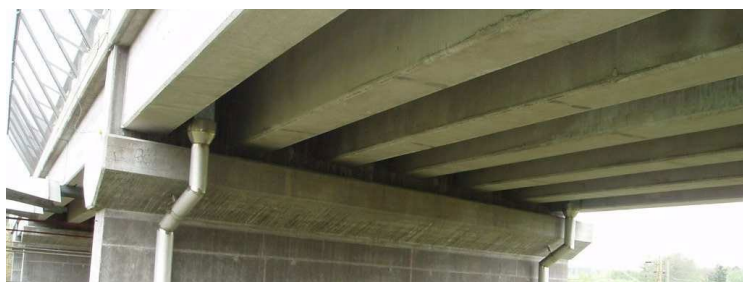
Figur 35. Bro med prefabricerade betongbalkar över järnväg norr om Osby. Foto från BaTMan
