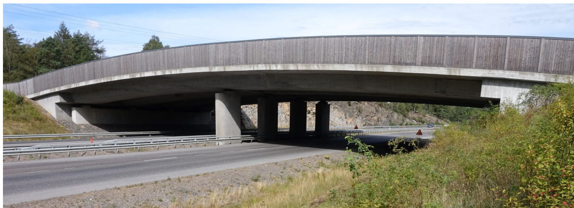
Figur 31. Ur gestaltningssynpunkt är det viktigt att faunaskärmen ansluter väl till landskapet och att den inte upplevs för hög ur trafikantsynpunkt. Foto från Ekodukt Sandsjöbacka, Mats Lindqvist
