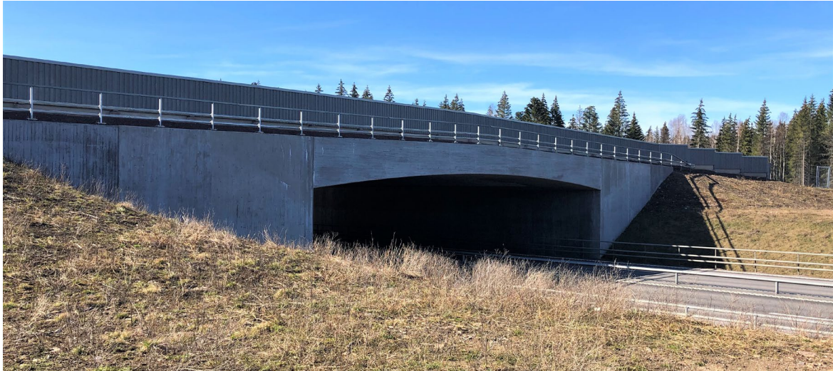
Figur 33. Faunabron vid Hova (knr: 100-296-1). Brons spännvidd över E20 är 26 m. Foto från BaTMan.
