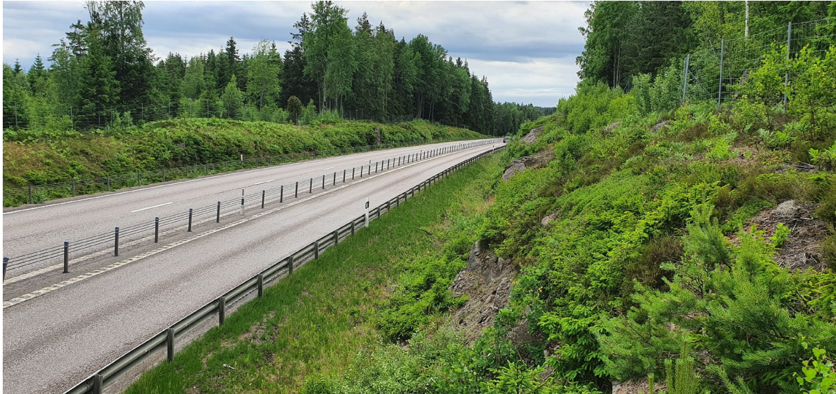
Figur 24. Föreslaget läge för en ca 28–30 m bred faunabro. Notera höjdstöd i terrängen på båda sidor av vägen. Foto: EnviroPlanning, Fredrik Winterås.
