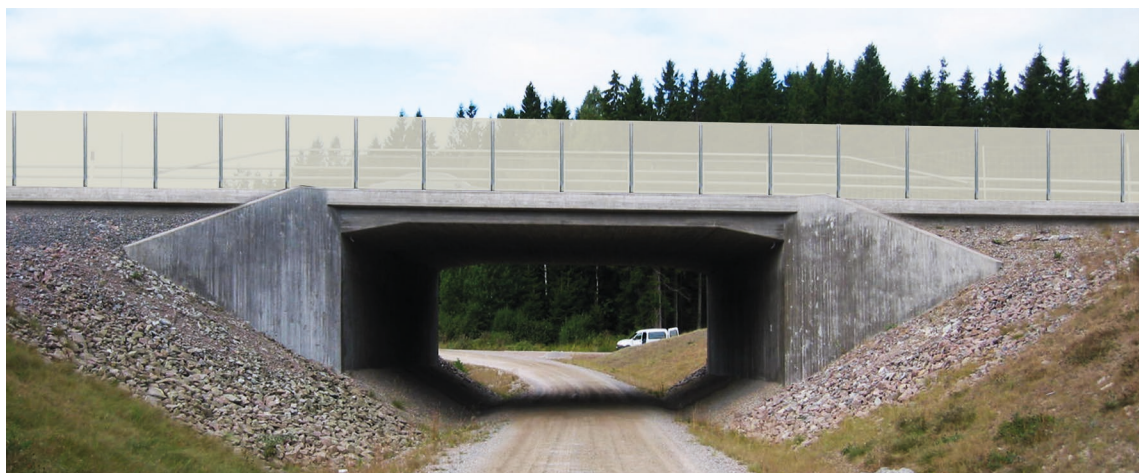
Figur 22. Illustration av tänkbar lösning med siktskärm på befintlig port. Siktskärmens skall dock inte vara transparent som i denna illustration. Illustration: EnviroPlanning.
