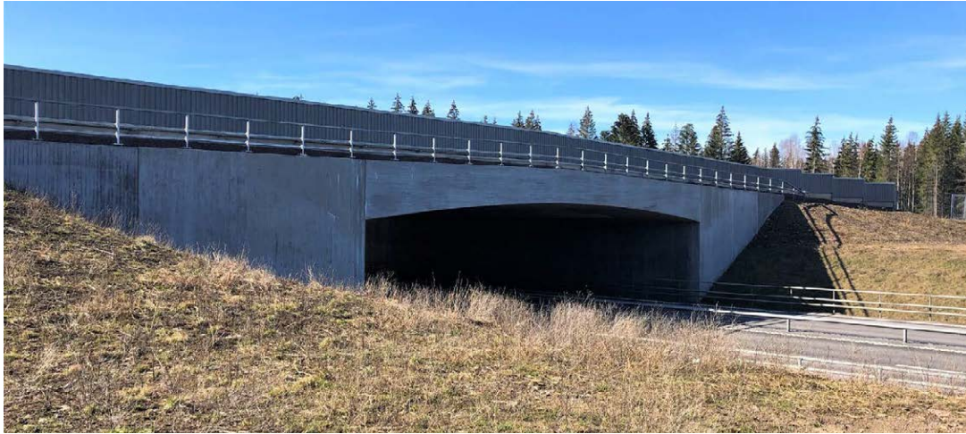
Figur 28. Faunabron vid Hova (knr: 100-296-1). Brons spännvidd över E20 är 26 m. Foto från BaTMan.
