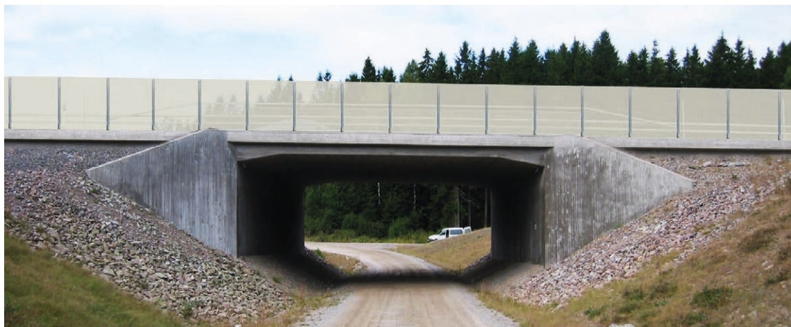
Figur 17. Illustration av tänkbar lösning med siktskärm på befintlig port. Siktskärmens skall dock inte vara transparent som i denna illustration. Illustration: EnviroPlanning.
