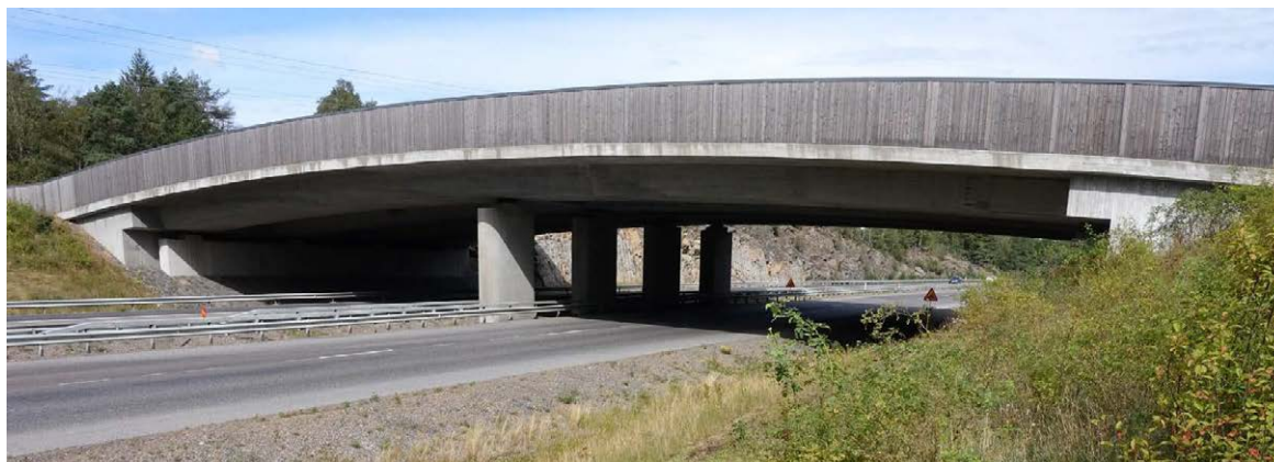
Figur 26. Ur gestaltningssynpunkt är det viktigt att faunaskärmen ansluter väl till landskapet och att den inte upplevs för hög ur trafikantsynpunkt. Foto från Ekodukt Sandsjöbacka, Mats Lindqvist
