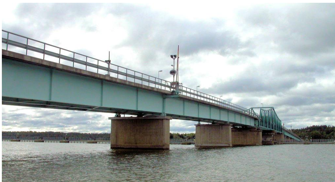
Figur 3 Befintlig bro fotograferad från sydväst.
