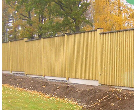
Figur 4.7 Bullerplank med trappning. Foto: Skandinaviska områdesskydd.
