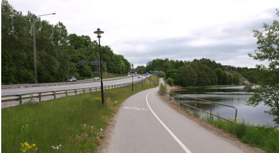
Figur 2.4. Befintlig gång- och cykelväg söder om Bergshamraleden, riktning mot öster. Gång- och cykeltrafiken delas med linjemålning.
