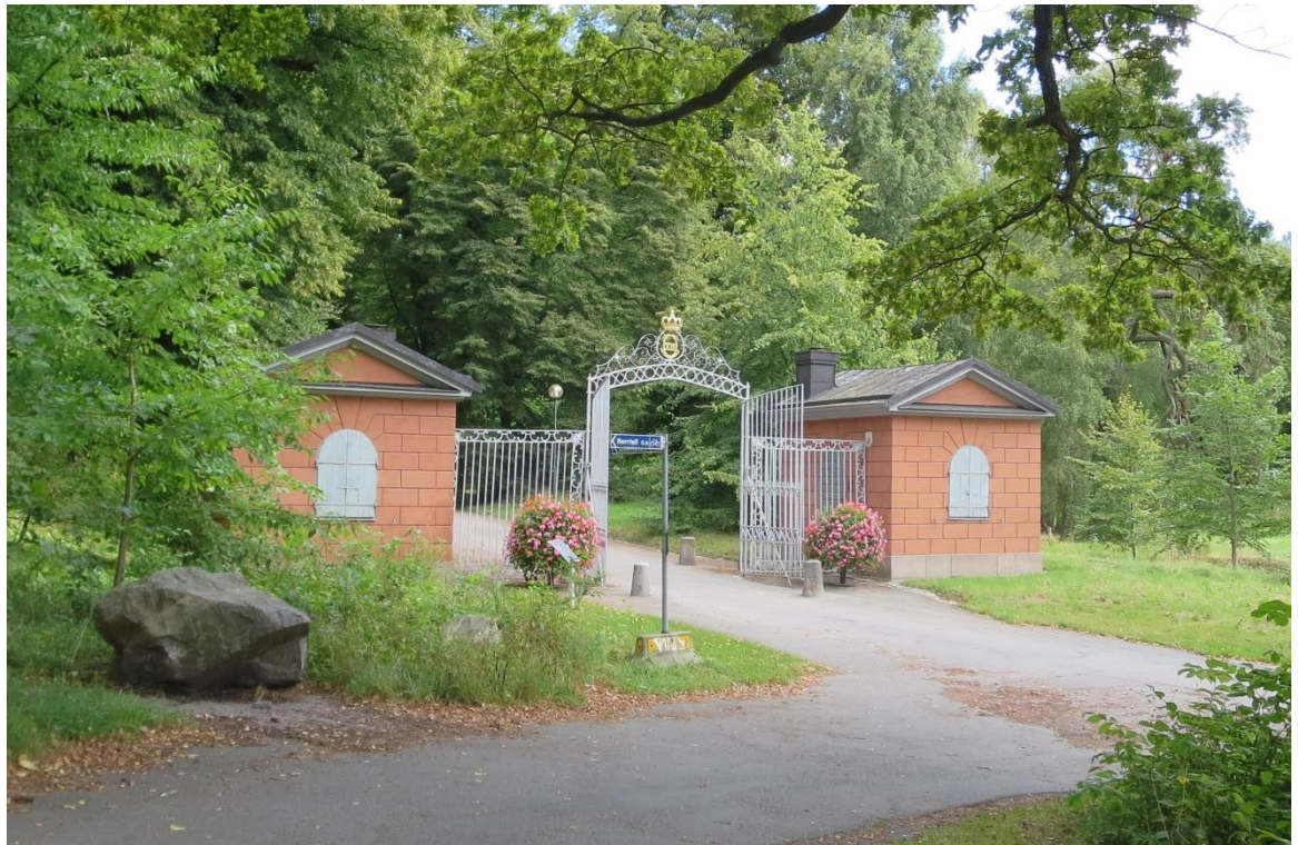
Haga södra grindar. Foto: WSP
