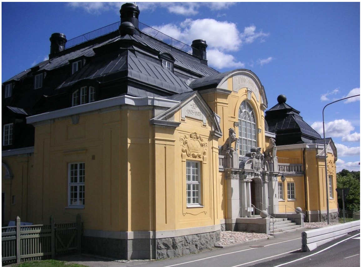
Haga tingshus sett från väster. Foto: Solna stad.
