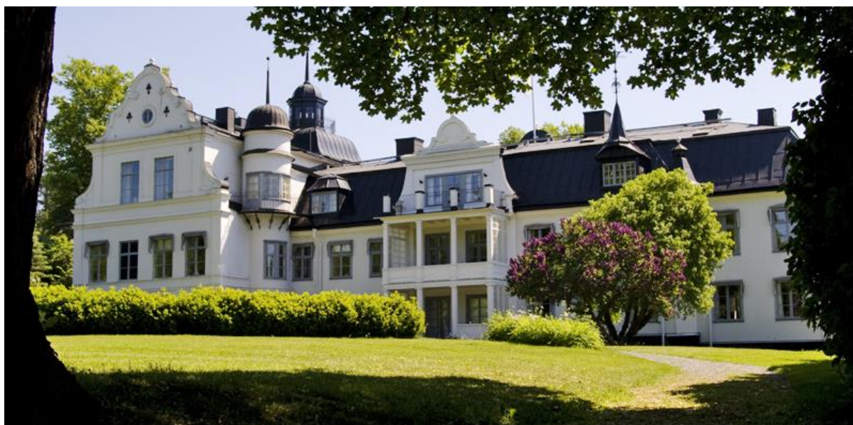
Huvudbyggnaden vid Stora Frösunda. Foto: Solna stad
