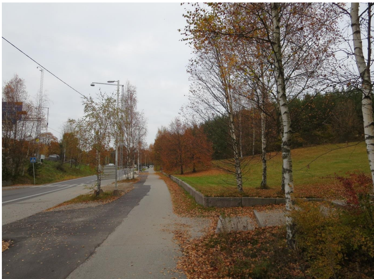
Befintlig gång- och cykelväg vid trafikplats Linvävartorpet. Foto: WSP
