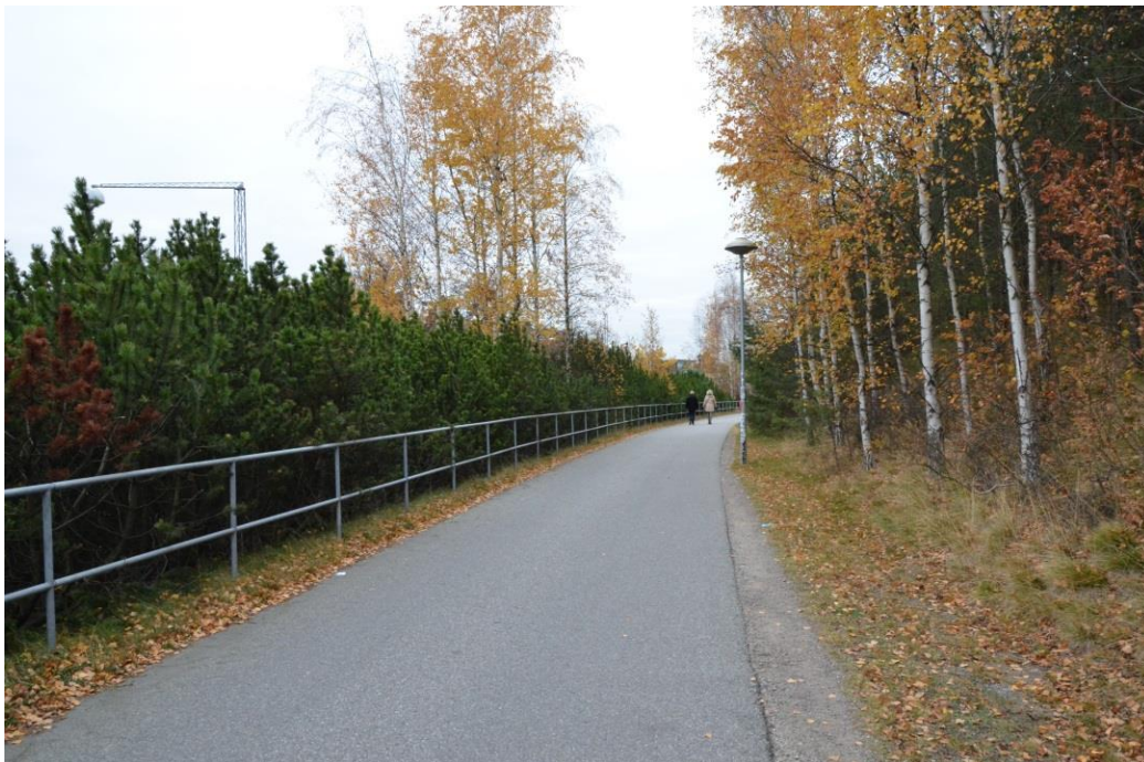
Figur 4. Befintlig gång- och cykelväg söder om Frösunda gångbro, norrgående riktning.
