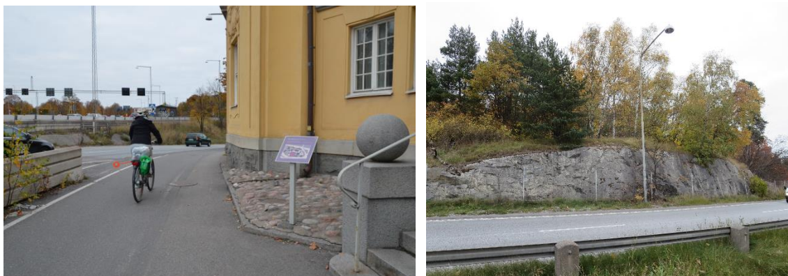
Figur 22. Till vänster befintlig gång- och cykelväg förbi Haga tingshus, till höger befintlig bergskärning vid trafikplats Haga södra. Foto: WSP.
