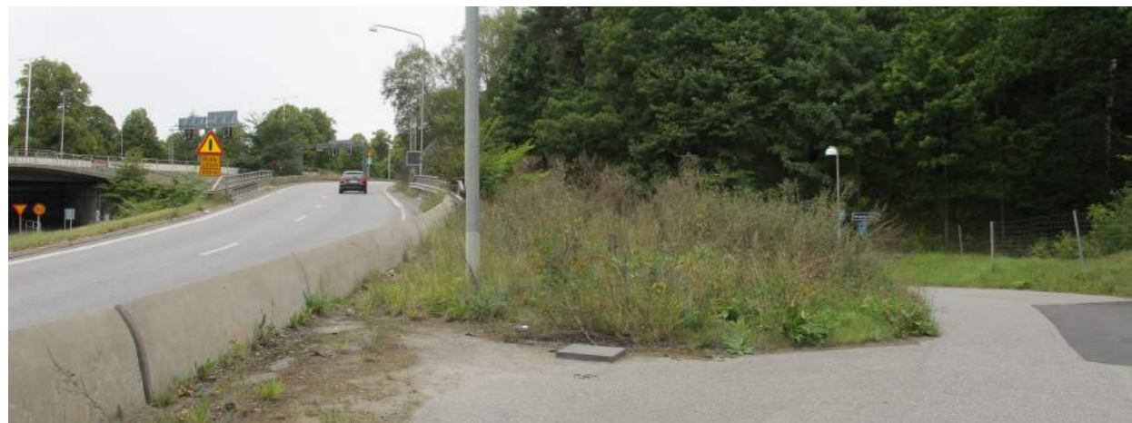
Figur 131. Befintlig gc-väg används som avfart från snabbcykelvägen till Haga södra grindar. Befintlig grönremsa med ogräs i anslutning till Haga södra entré föreslås rustas upp med en ny plantering med lägre buskar, (som ej skymmer sikten för cyklister) som ger ett mer inbjudande intryck till entréområdet. Foto: WSP
