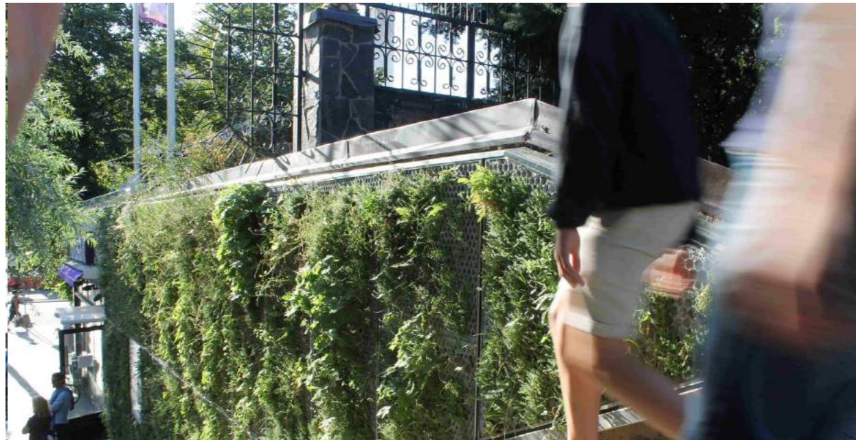
Figur 179-180. Brons stödmurar och bropelare kläs med gröna växtpaneler samt med vajrar för klättrväxter för att få ett mjukt, grönt uttryck som harmoniserar med den befintliga karaktären vid Brunnviken. Se s. 138-141 för utbredning av växtväggarna och vajrarna för klättrväxter. Stödmurarna och bropelarna skyddas på så sätt mot klotter. Förslag på arter att använda är växter som normalt växer vid havsstränder, till exempel Strandtrift och Kustglim. För att få en biologisk mångfald behövs ett 20 tal arter. De inhemska arterna kan kompletteras med arter från saltstäppen i Centralasien för att få en bra och tålig sammansättning. Infästning på bropelarna görs med metallband runt pelarna som förankras ca 40-50mm djupt i ett fåtalpunkter på varje pelare. Luftspalt finns mellan pelare och butongelement varpå inspektion av bropelare kan ske med kamera och vid behov kan panel skruvas ned. Bevattning föreslås lösas genom utanpåliggande ränna med stuprör som leds till respektive pelare. Stödbevattning kan vara aktuellt under längre torra perioder eller stora temperaturskiftningar. Alternativt system med pump/depåer. Skötsel beräknas ske ca 3-4ggr per år. Foton: Butong och VR modell.
