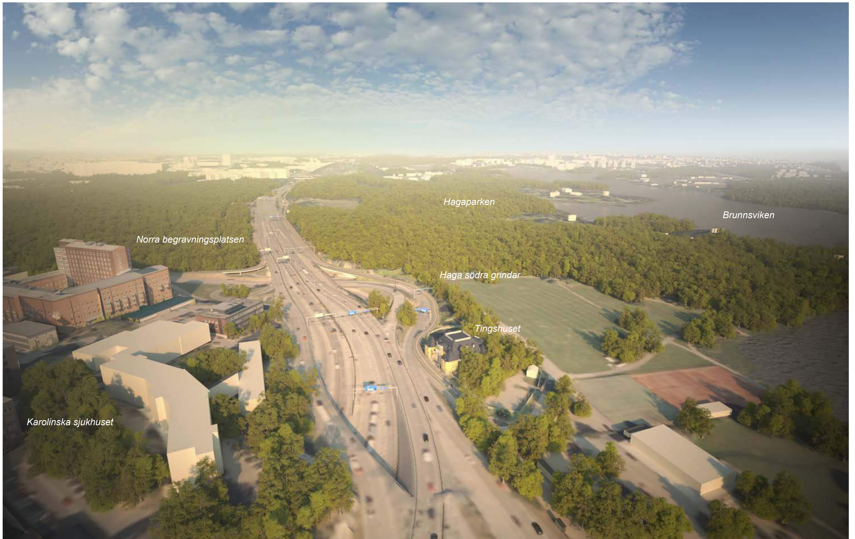
Figur 127. Flygbild över Haga södra. Vid Haga södra görs en mindre bergskärning cirka en decimeter hög precis i slutet av rampen på sträckan 0/290-0/320. Norr om entrén vid Haga södra anläggs cykelvägen invid E4 N. En ny bergskärning görs i befintlig bergskärning på sträckan 0/350-0/432.
