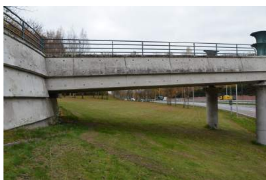
Figur 136. Befintlig gc-bro vid Haga norra. Foto:WSP
