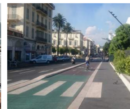
Figur 63. Bild. Färgad asfalt i korsning med gående, Nice. Foto:WSP
