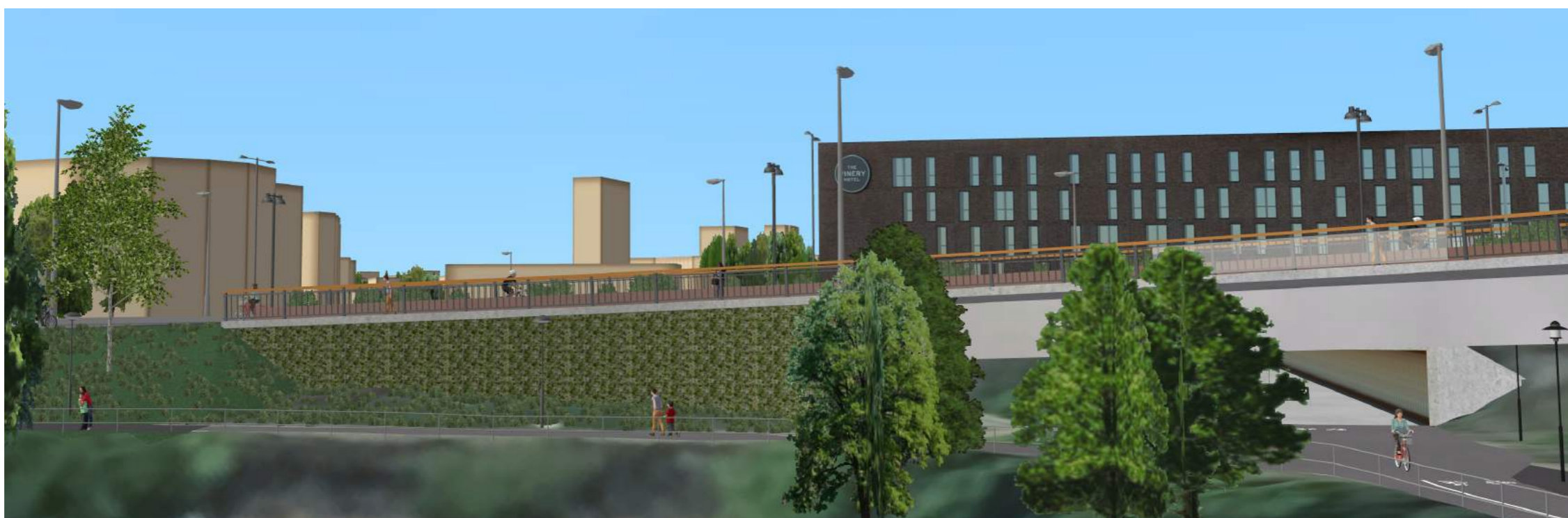
Figur 95. Stödmurar vid den nya gång- och cykelbrons södra landfäste vad ca 3/370. Stödmurarna kläs med gröna växtväggar så kallade butongpaneler med pluggplanter för ett grönt intryck och som skyddar muren mot klotter. De gröna stödmurarna förstärker park- och naturmiljön vid Brunnsviken, gynnar insekter och biologisk mångfald.
