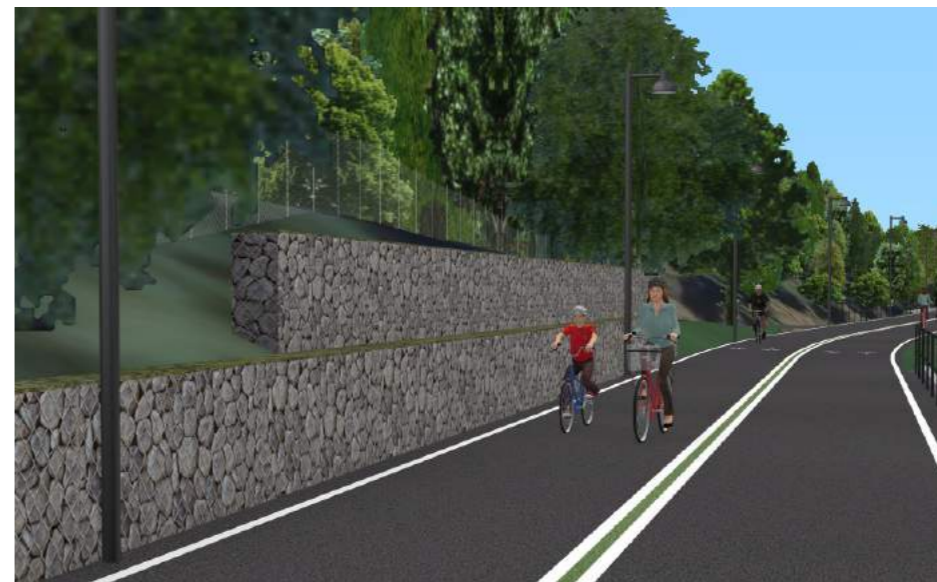
Figur 99. Vy som visar förslag på gabionmur.
