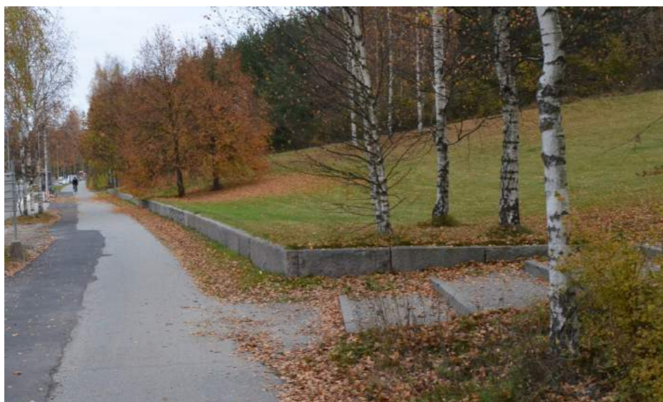
Figur 83. Befintlig blockstensmur i granit vid Linvävarporpet som flyttas. Foto: WSP
