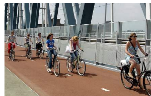
Figur 62. Inspirationsbild från bron Snelbinder i Nijmegen, Holland som visar en bred dubbelriktad cykelbana med färgad asfalt för att tydliggöra var man cyklar och var man går. Foto: Arnhem Nijmegen City-Region
